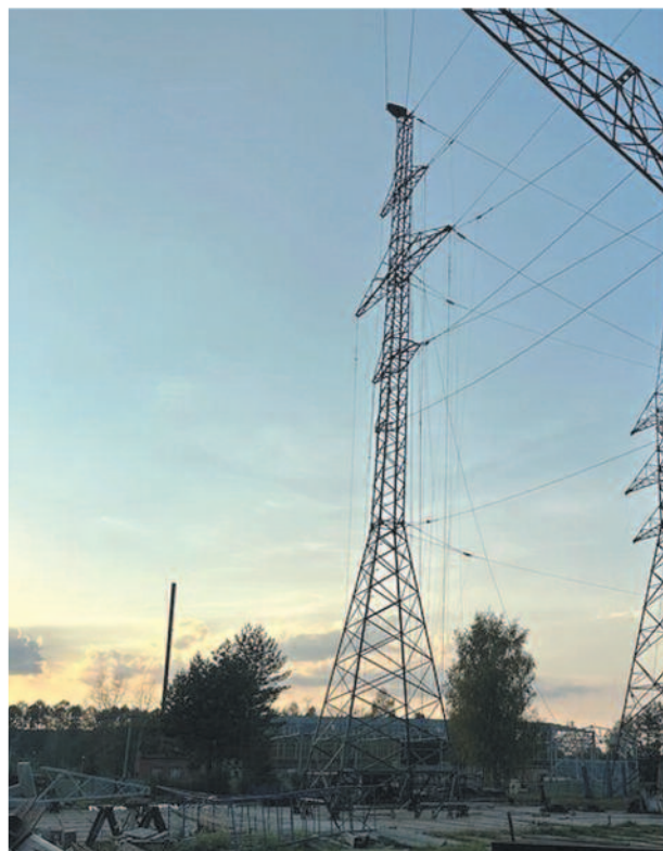
Рис. 5. Испытание промежуточной опоры
