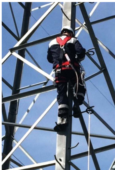
Рис. 8. Проверка использования степ-болтов с анкерными точками на полигоне ПС 500 кВ «Белый Раст» в 2018 г.
