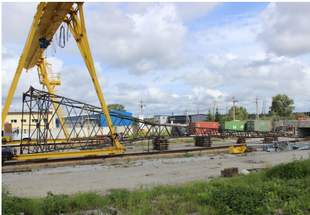
Завод ООО «ЭК «ЗМК Энерго», контрольная сборка, август 2024
