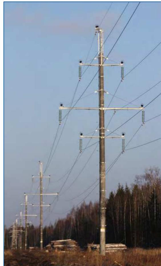
**СПБ110-4 и СПБ110-8Ф** Для технологического присоединения энергопринимающих устройств ПАО «Газпром»
