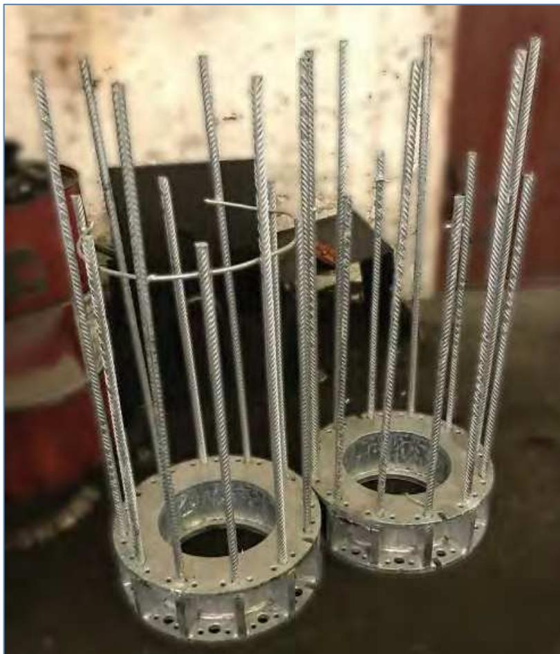
Закладные детали внутреннего соединительного узла
