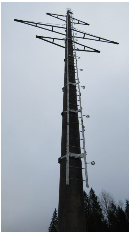
Двухцепная опора СПБ110-6
