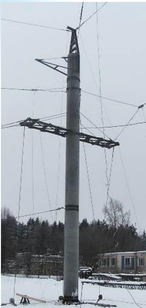
Одноцепная анкерно-угловая опора, декабрь 2016
