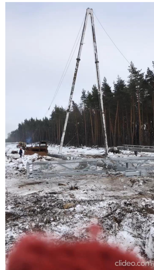
Строительство опоры 2СПБ500-3В, январь 2019
