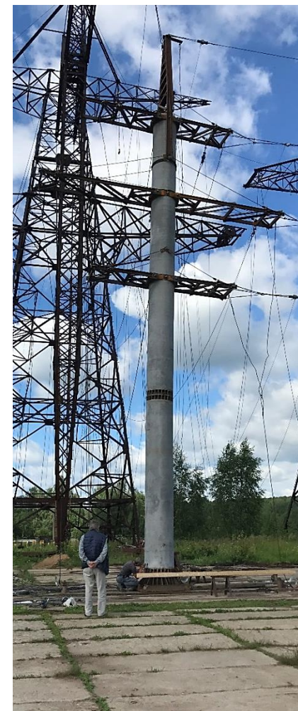
Двухцепная анкерно-угловая опора, июль 2017
