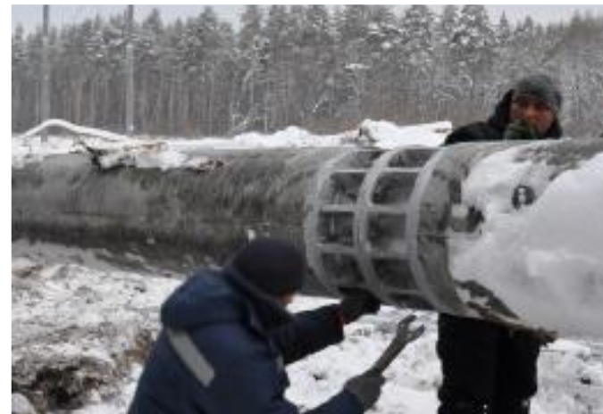
Сборка секций стойки
