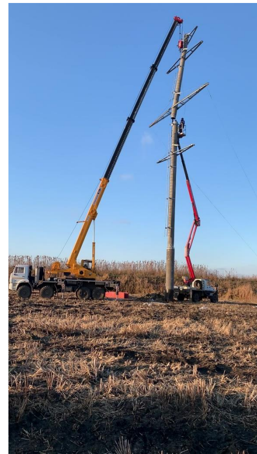
Монтаж верхней секции опоры
