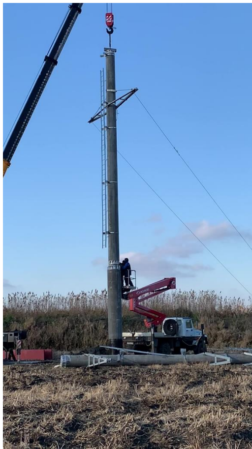
Монтаж средней секции опоры
