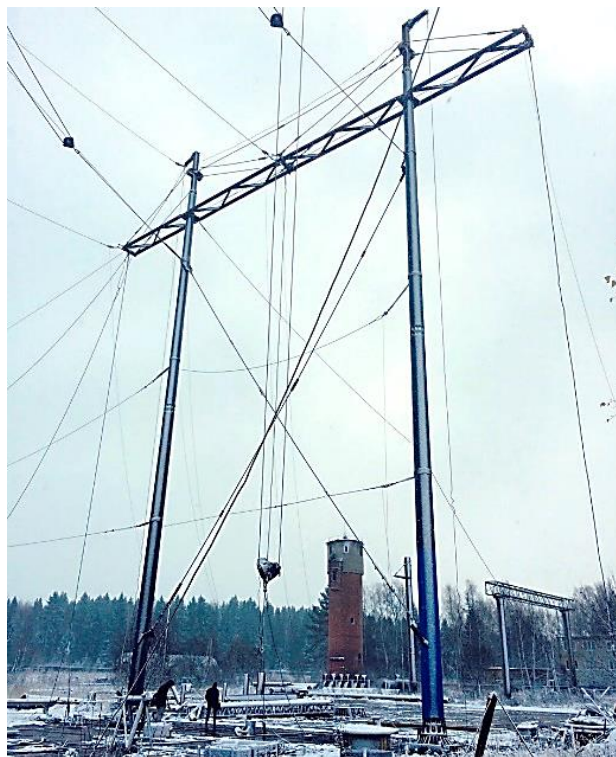
Испытания опоры 2СПБ500-3В на полигоне ОРГРЭС, май 2015
