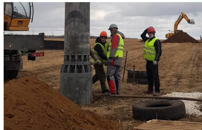
Установка опоры на фундамент
