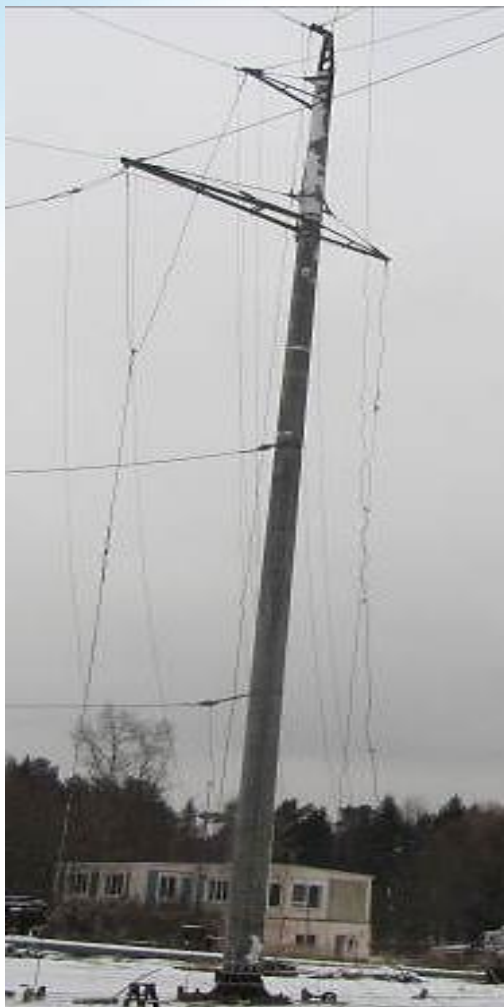
Одноцепная промежуточная повышенная опора, ноябрь 2016
