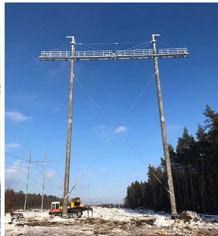
Опора на линии, январь 2019
