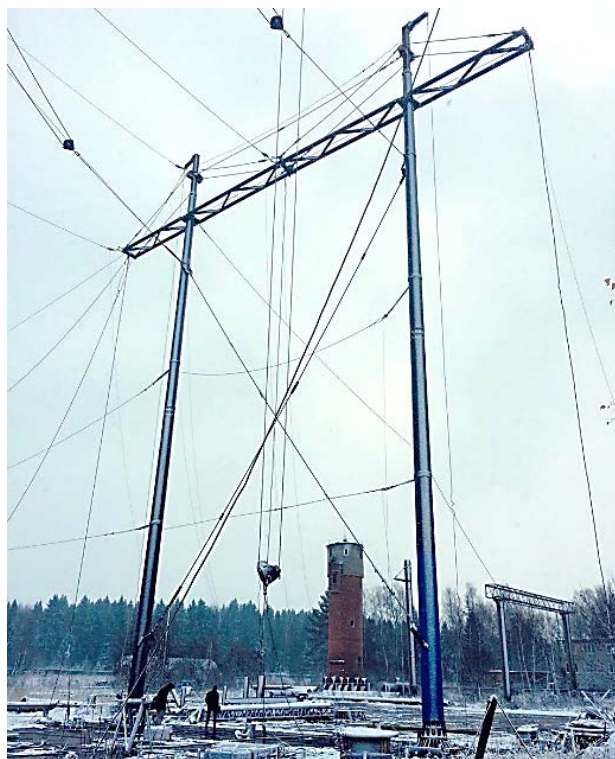
Испытания опоры на полигоне ОРГРЭС, май 2015
