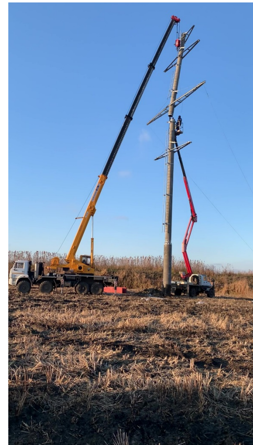
Монтаж верхней секции опоры
