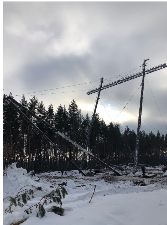
Подъём опоры методом падающей стрелы
