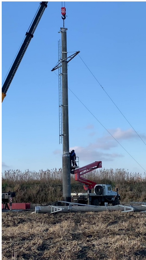
Монтаж средней секции опоры
