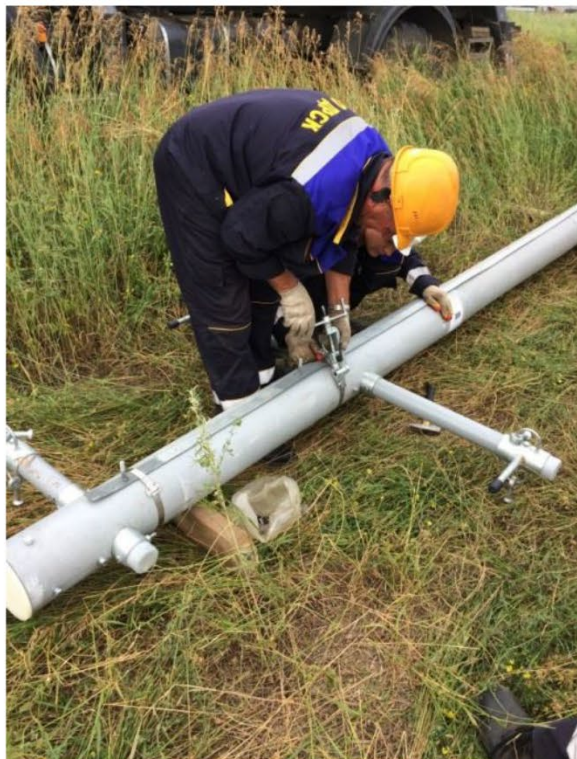
Сборка опоры на пикете
