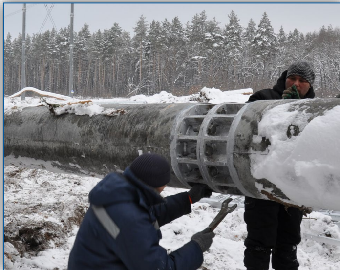
Сборка секций стойки
