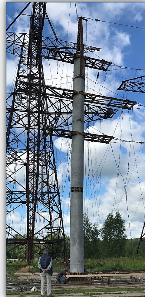
Двухцепная анкерно-угловая опора, июль 2017
