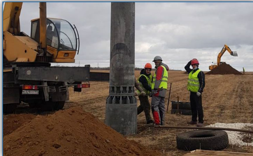
Установка опоры на фундамент
