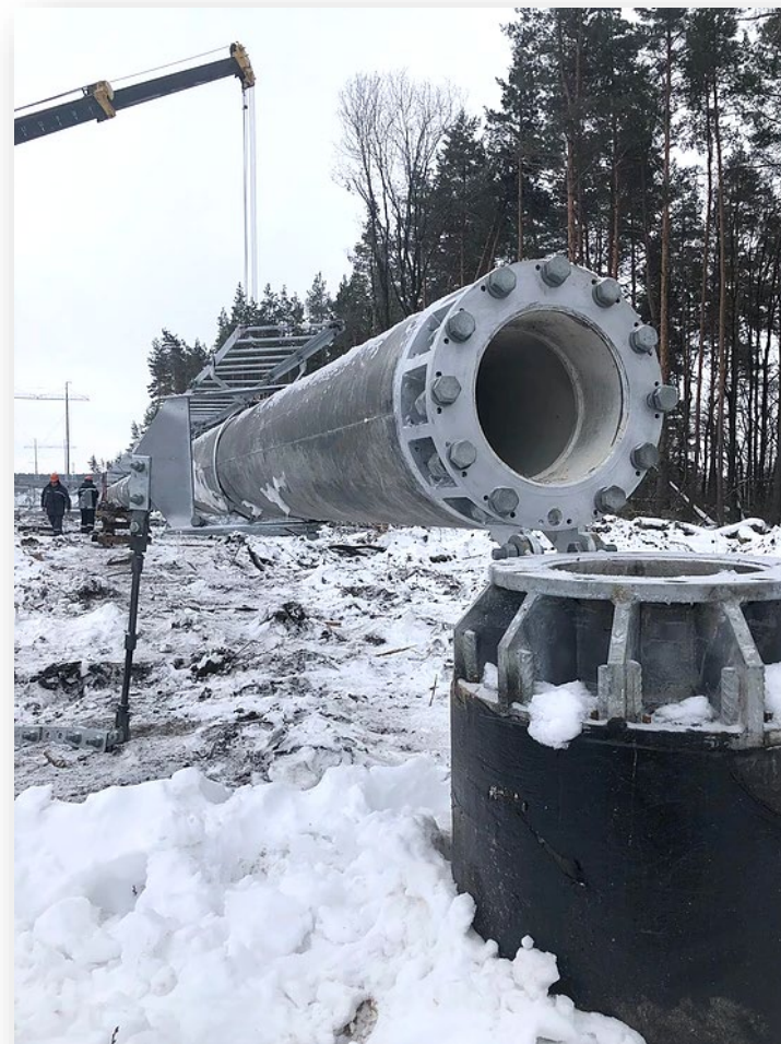
Монтаж элементов опоры, январь 2019
