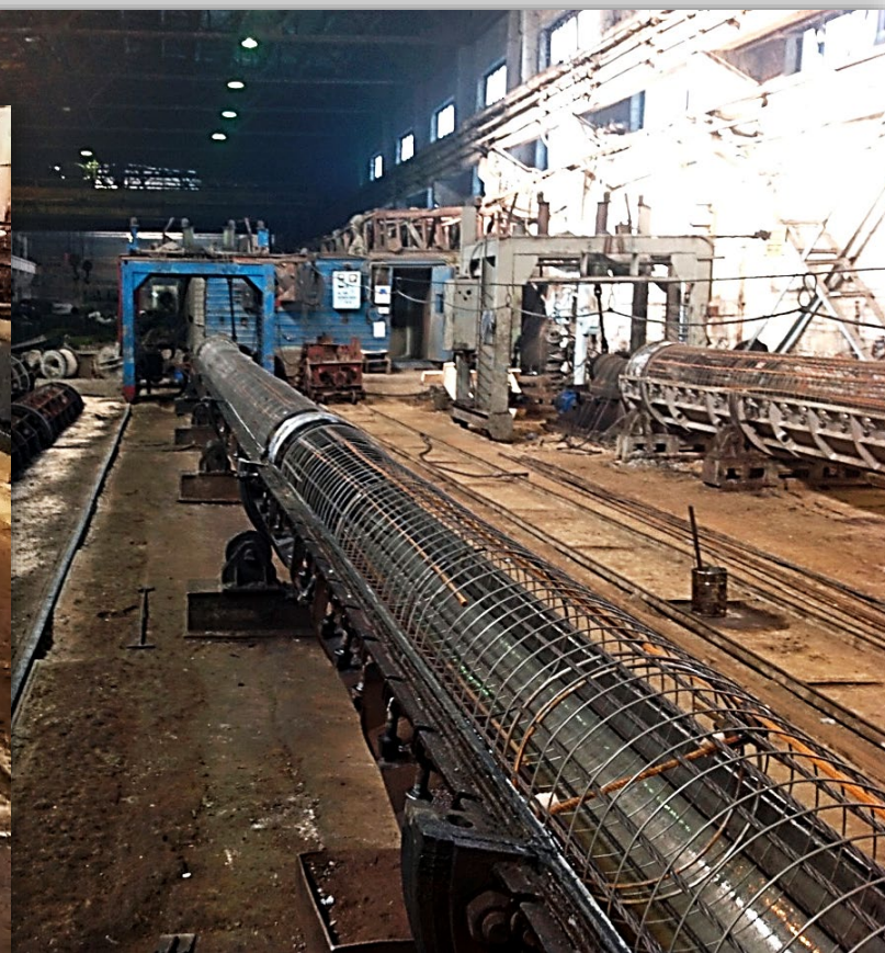
Арматурный каркас в металлоформе
