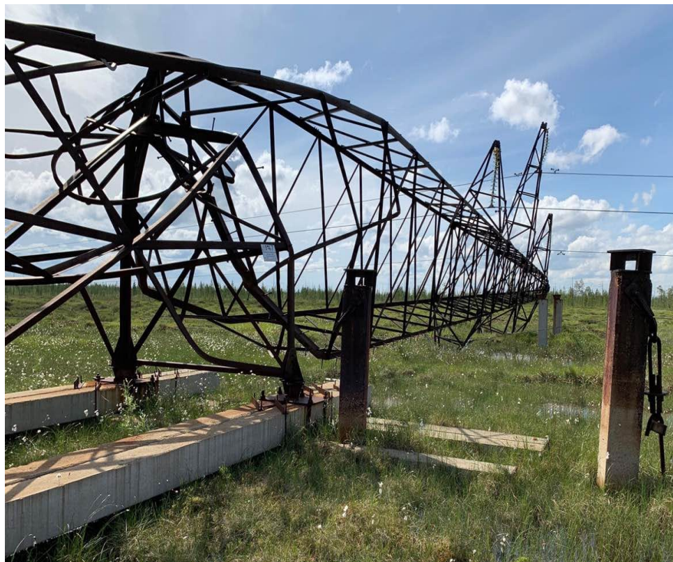
Опора П220-2 июнь 2019
