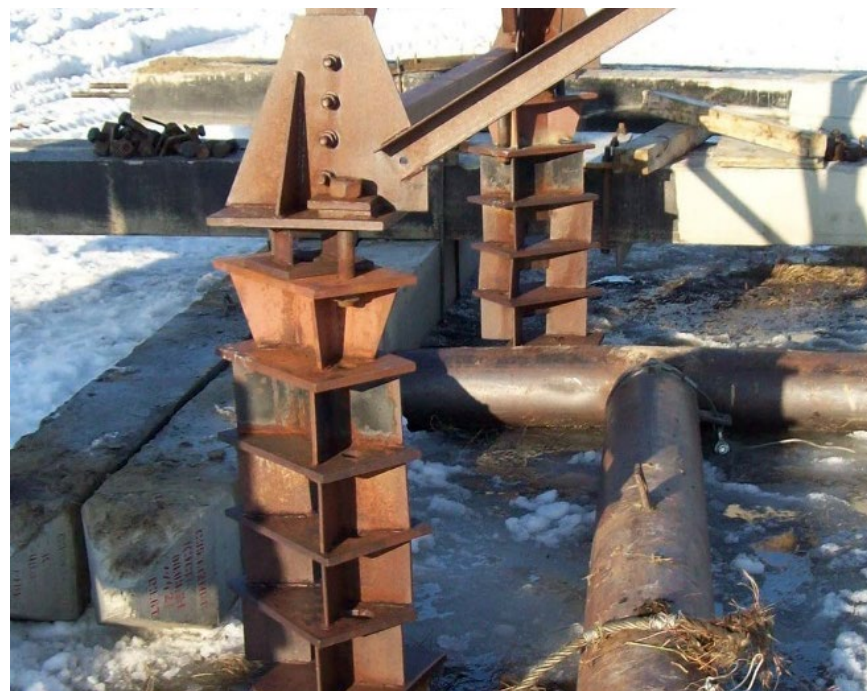
«Столики» для выравнивания свайных фундаментов
