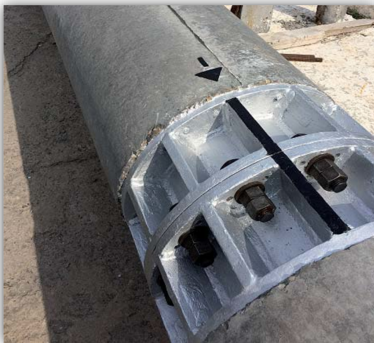
Внутреннее фланцевое соединение
