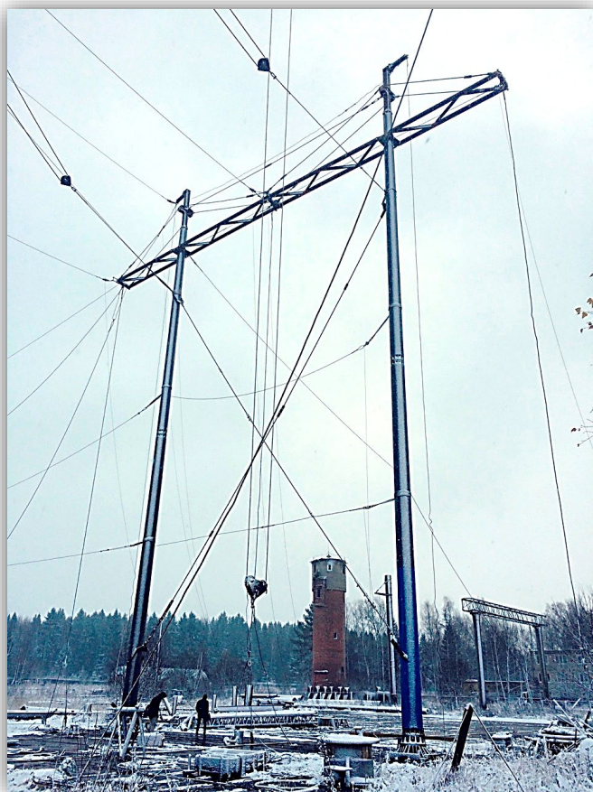
Испытания опоры 2СПБ500-3В на полигоне ОРГРЭС, май 2015
