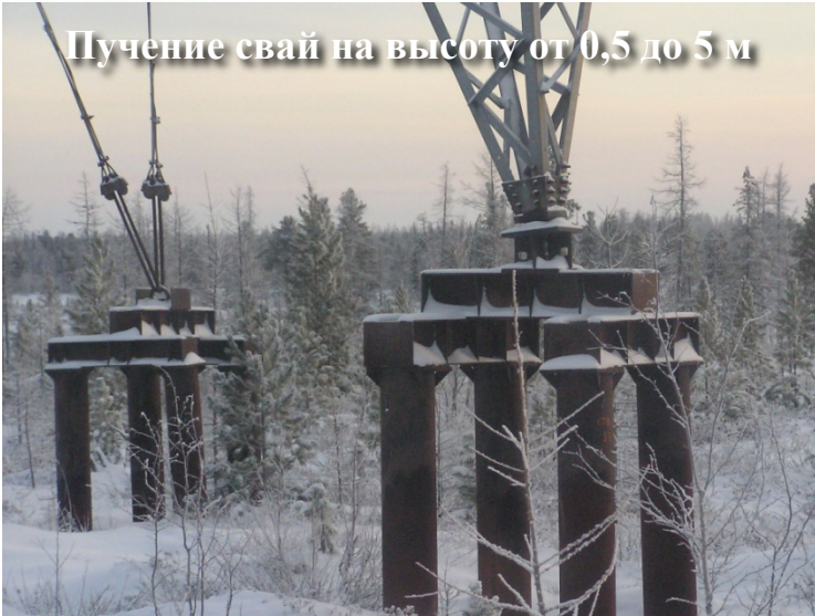
Неравномерное пучение свай под опорой
