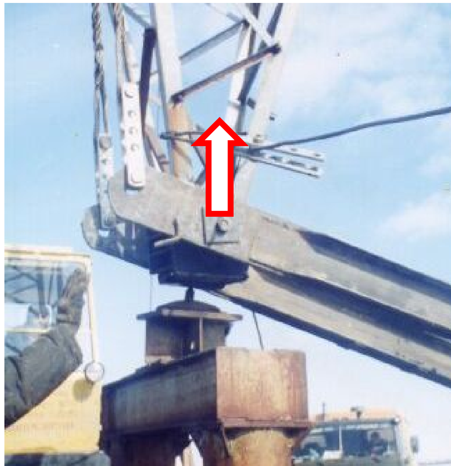
Подъем стойки опоры с опорного узла фундамента
