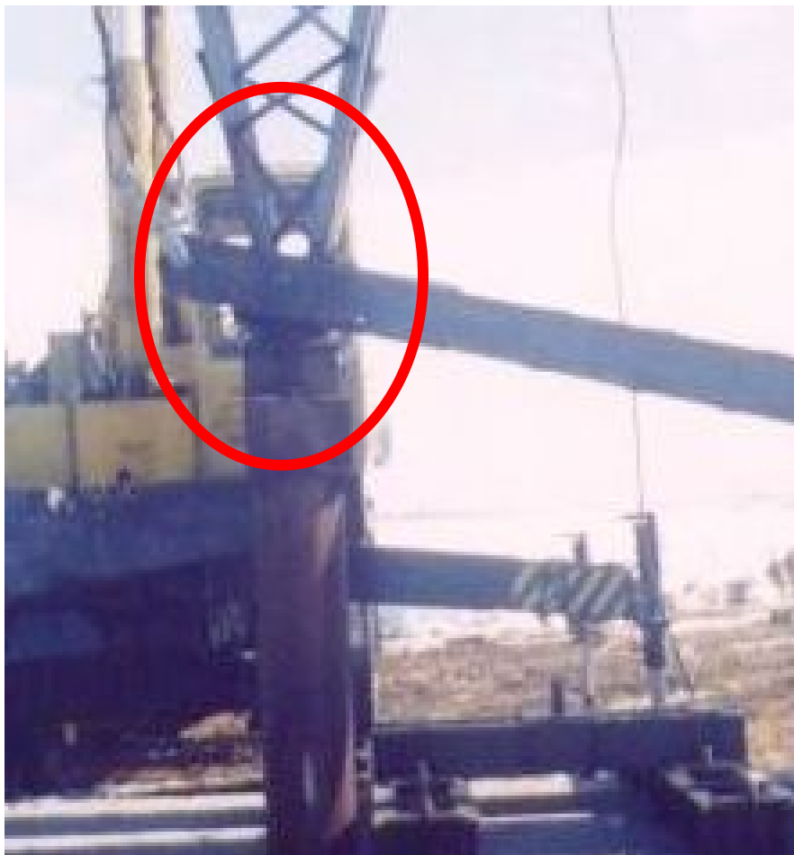
Захват опорного узла стойки опоры
