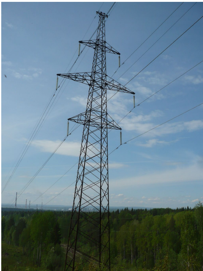
Марка опоры: П220-2т Типовой Проект 3.407-100 1973 г.
