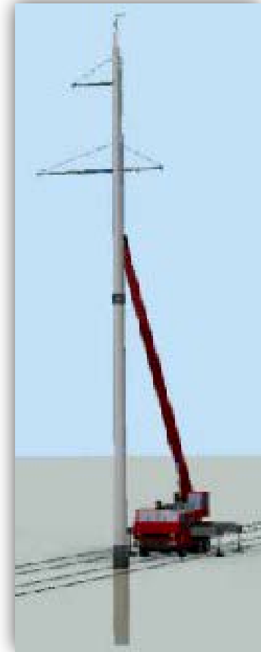
Установка железобетонной секционированной опоры на фундамент
