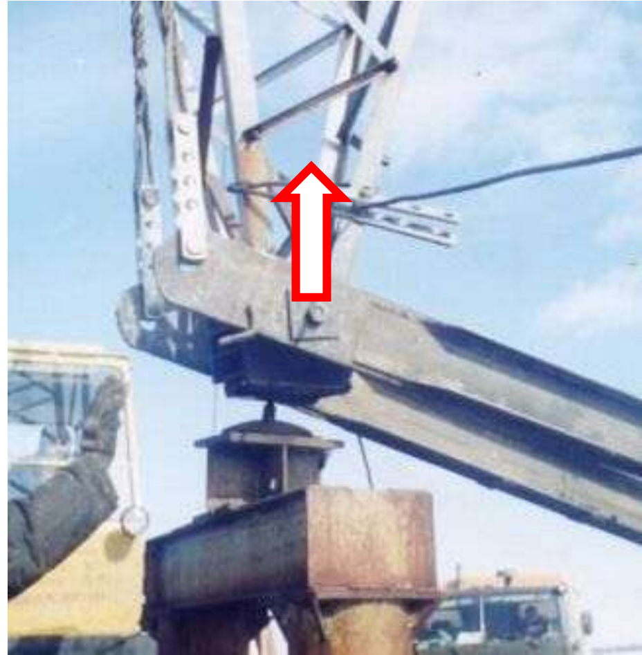
Подъем стойки опоры с опорного узла фундамента
