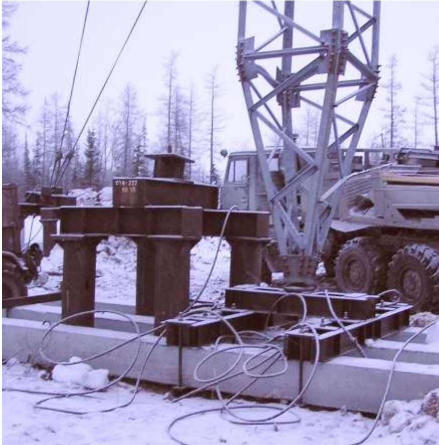
Перенесенная и установленная на поверхностный фундамент стойка промежуточной опоры ПБ1
