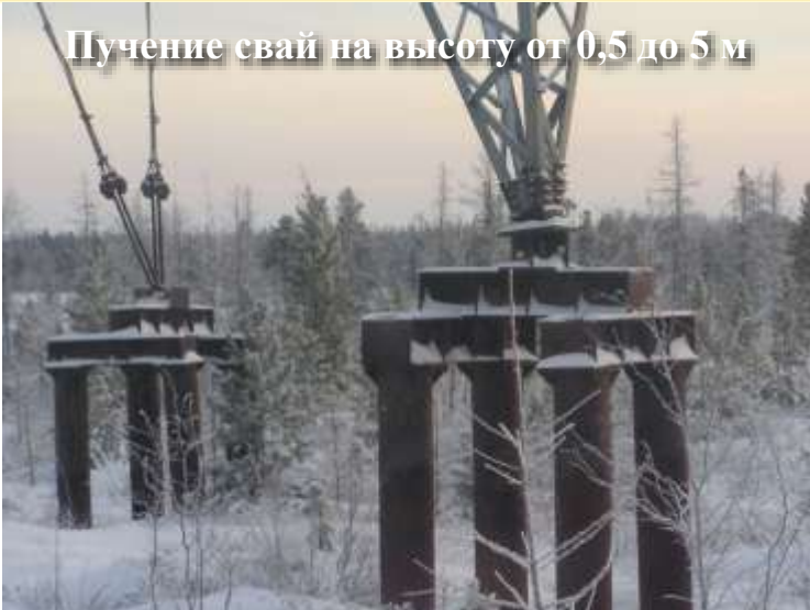
Неравномерное пучение свай под опорой
