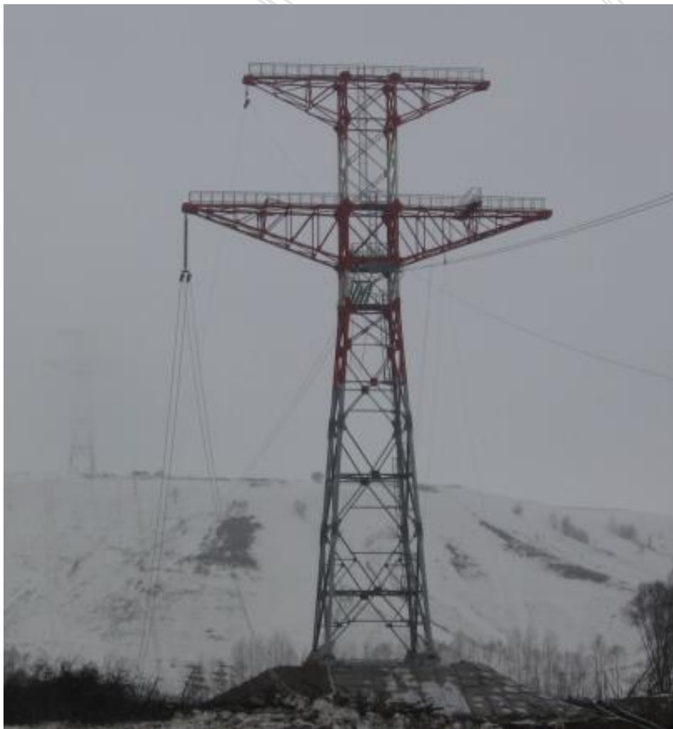
Переходная опора ПП500-1/52 со «встроенным» шарниром.
