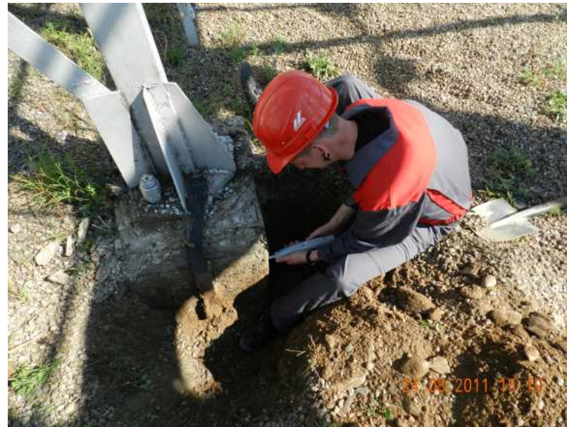
Линейный портал ОРУ 220 кВ Определение остаточной прочности бетона фундамента склерометром ОМШ-1
