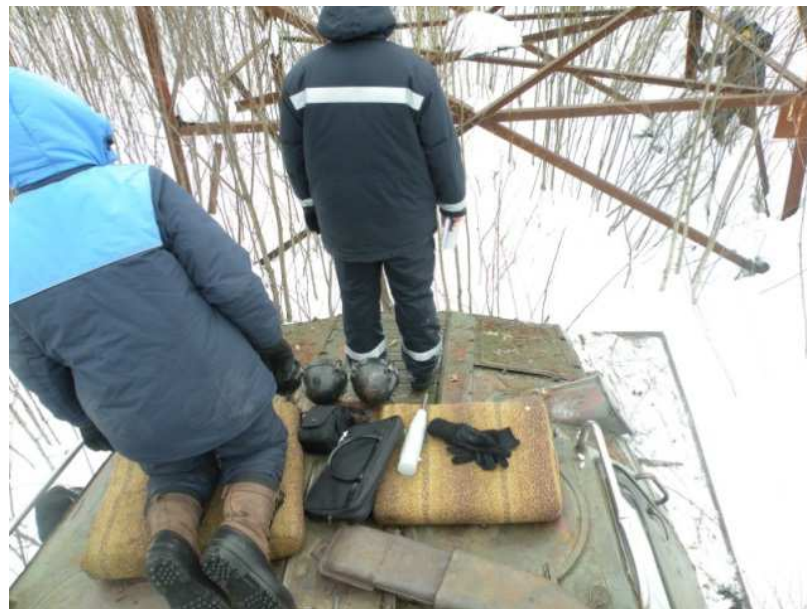
Обследование технического состояния металлической опоры
