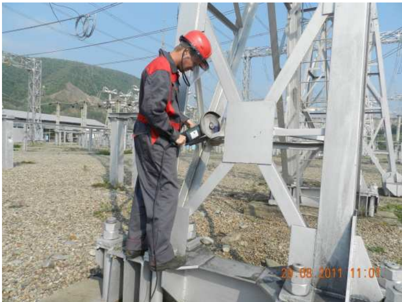
Шинный портал ОРУ 500 кВ Отбор образцов металла
