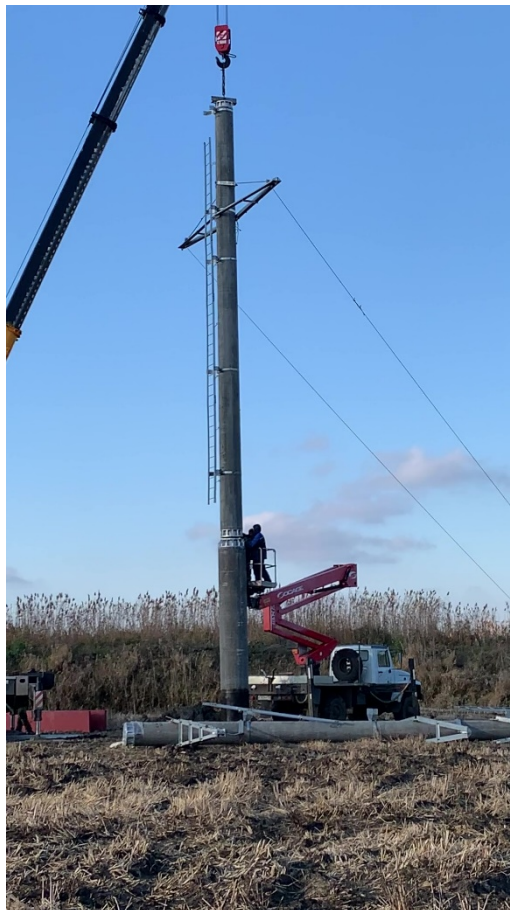
Монтаж средней секции опоры
