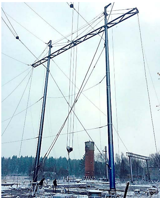
Испытания опоры на полигоне ОРГРЭС, май 2015
