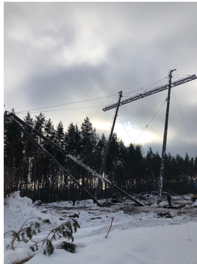
Подъём опоры методом падающей стрелы
