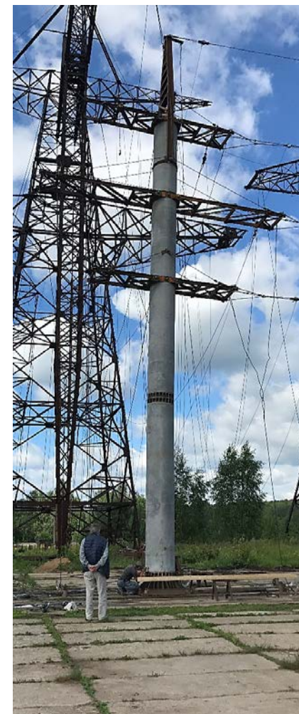
Двухцепная анкерно-угловая опора, июль 2017
