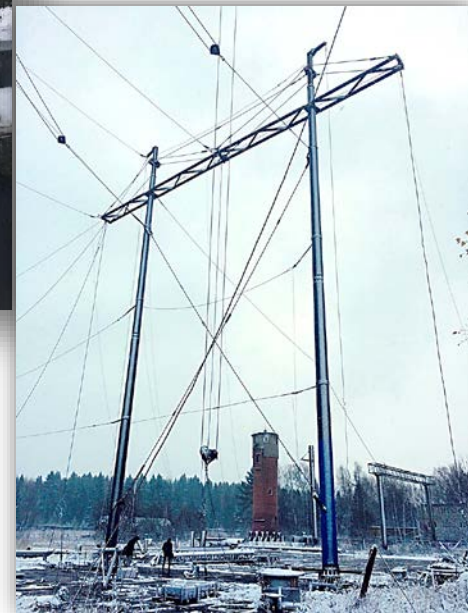
Испытания опоры 2СПБ500-3В на полигоне ОРГРЭС, май 2015
