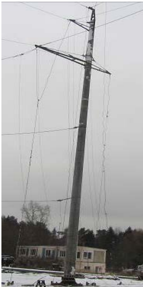
Одноцепная промежуточная повышенная опора, ноябрь 2016
