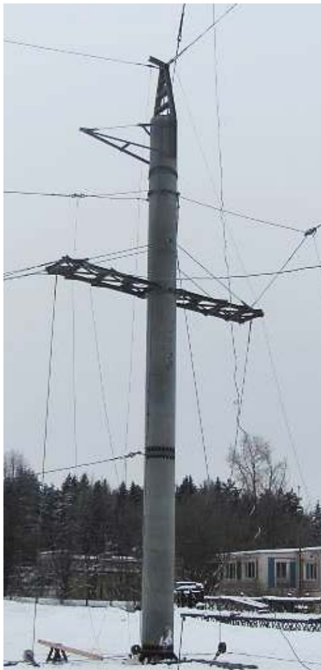
Одноцепная анкерно-угловая опора, декабрь 2016
