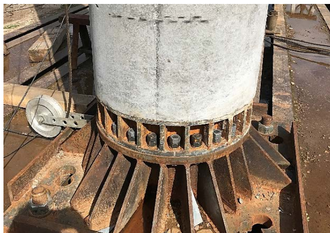
Узел крепления к силовому полу
