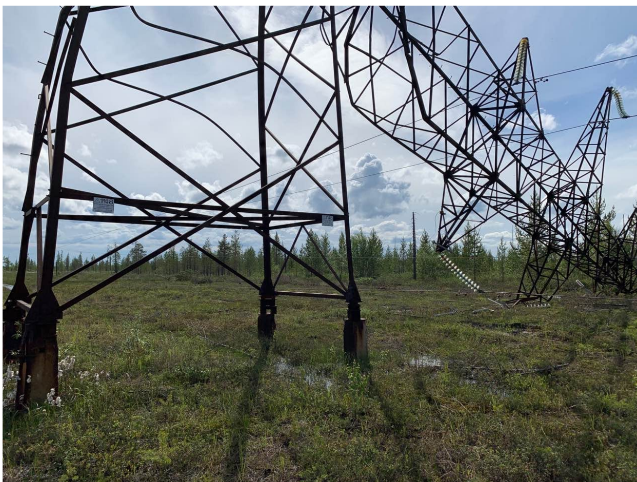
Рис. 1. Опора на свайном фундаменте
