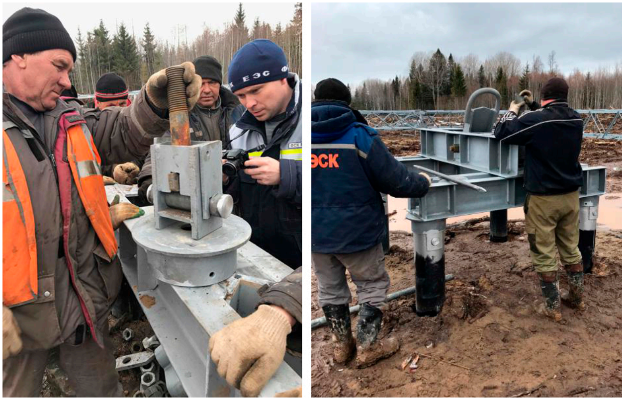
Рис. 5 Сборка фундамента под опору №99 ВЛ 750 кВ «Белозерская» - «Ленинградская»
