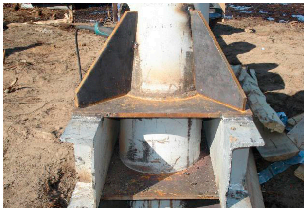
Рис. 1 Сварной узел соединения винтовой сваи с ростверком проекта серии 2000бтм
