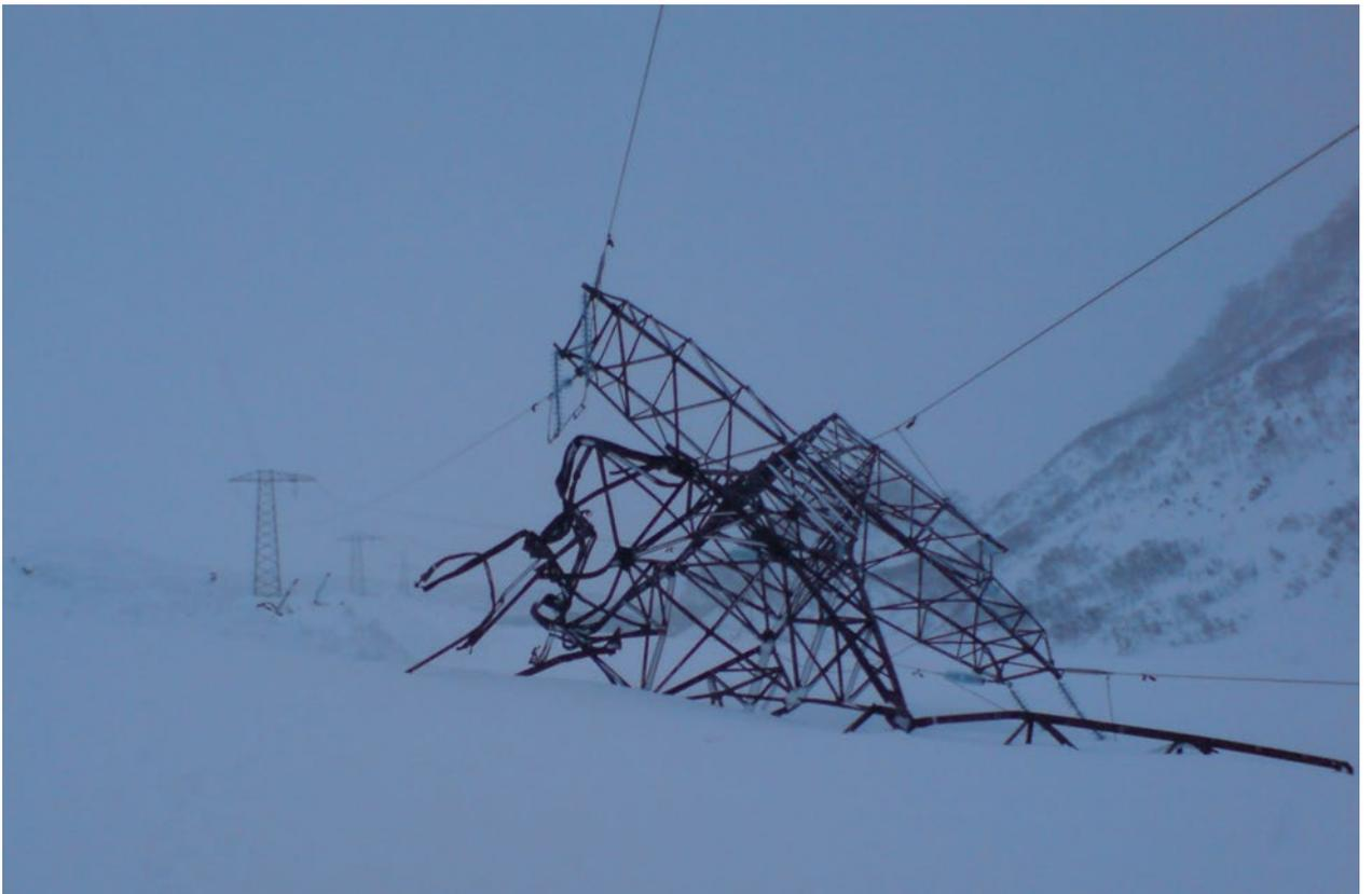
Рис. 1. Опора ВЛ 220 кВ, разрушенная воздействием снежной лавины.
