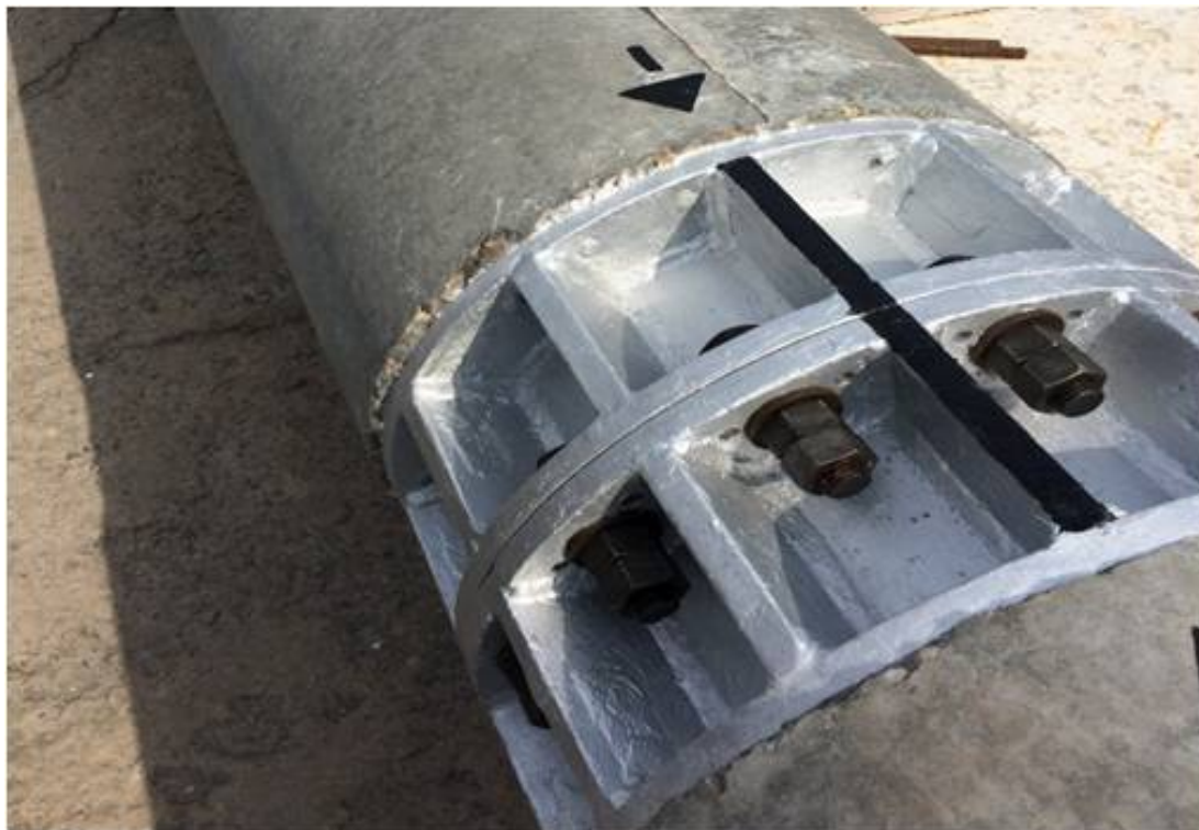
Рис. 1. Внутренний фланец для соединения секций
