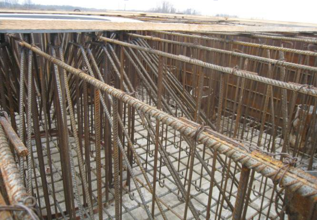
Арматурный каркас ростверка
