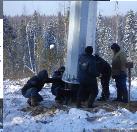
Установка опоры на фланец фундаментной секции
