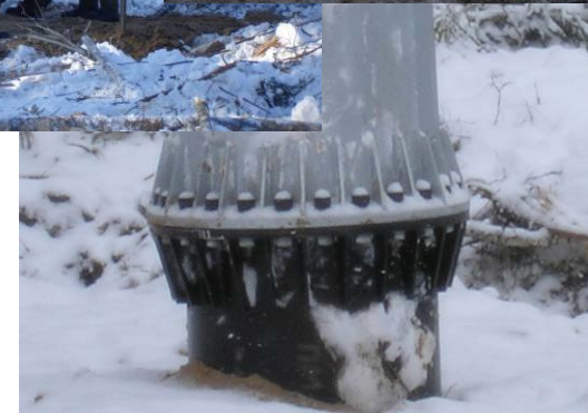
Узел крепления опоры к фундаменту
