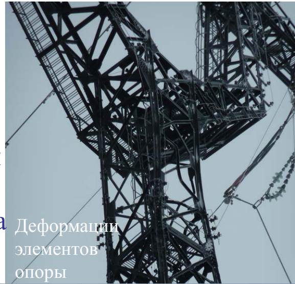
Переходная опора ПС-90 № 23 после динамического удара
