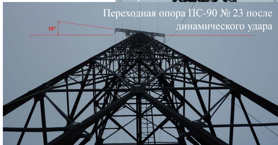
Деформации элементов опоры
