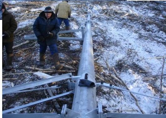
Стыковка секций, монтаж траверс и тросостойки
