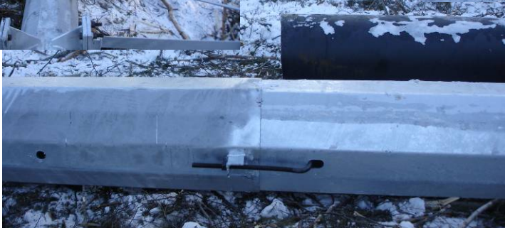
Стыковка секций, монтаж траверс и тросостойки
