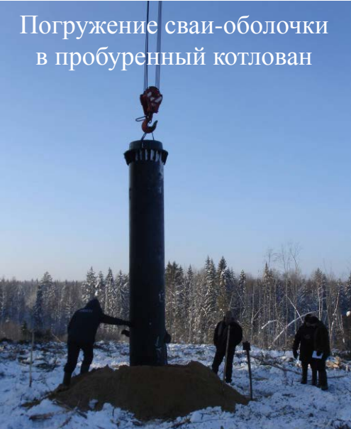
Подъём опоры с помощью крана
