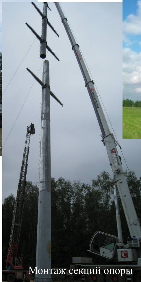
Монтаж секций опоры
