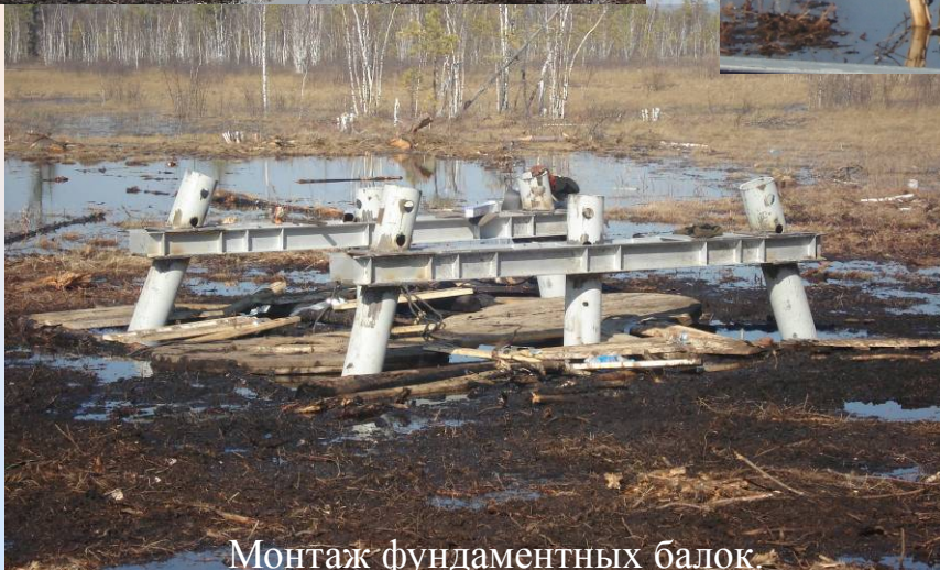
Погруженные винтовые сваи.
