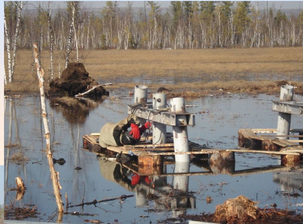
Монтаж фундаментов опоры на оттяжках.
