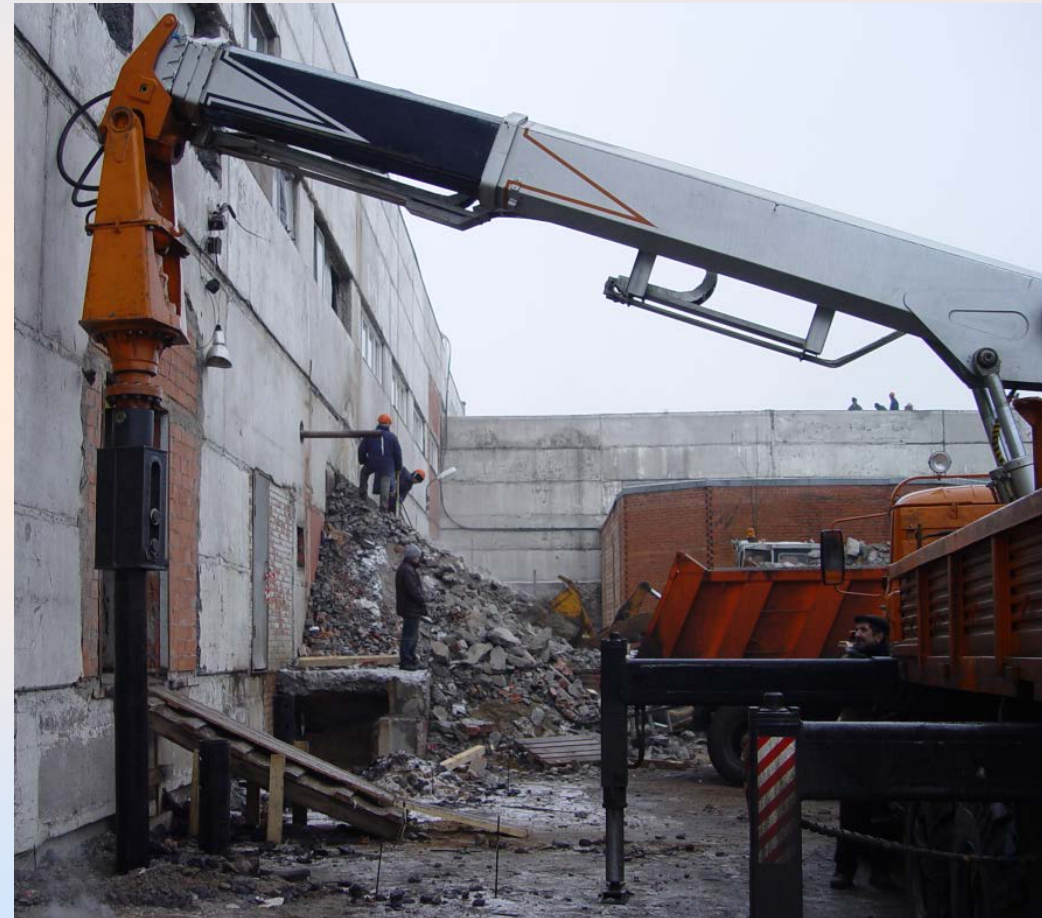
Установка винтовой сваи в непосредственной близости к застройке.
