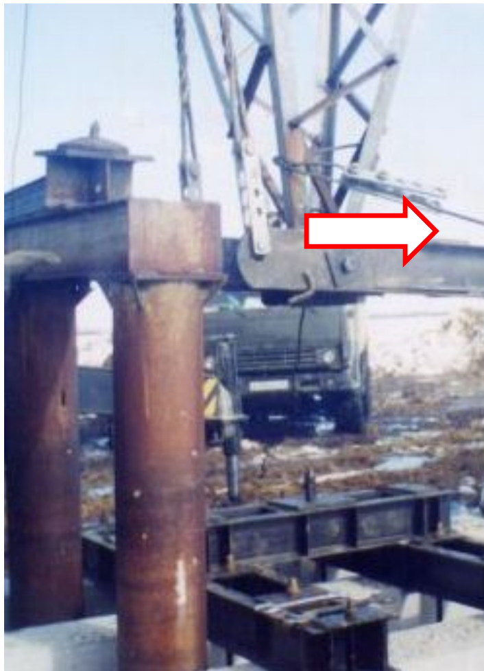
Сдвиг стойки опоры по горизонтали и опускание ее на фундамент
