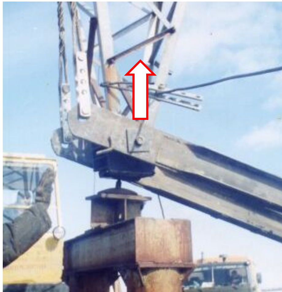
Подъем стойки опоры с опорного узла
