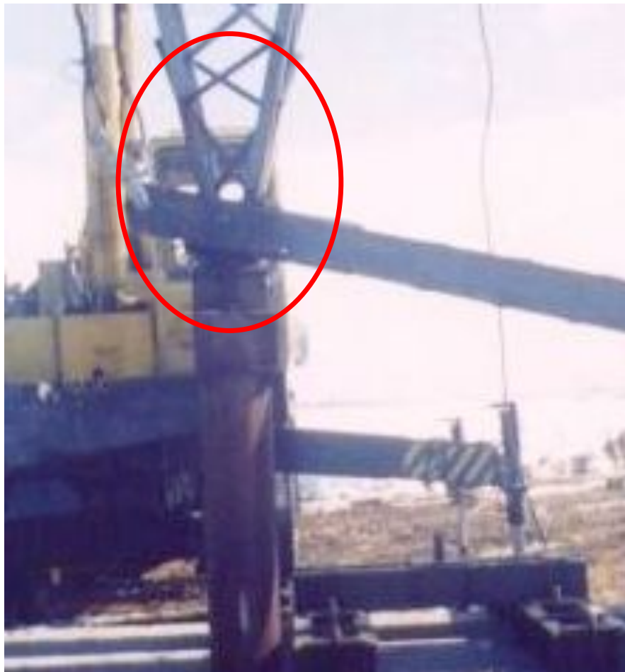
Захват опорного узла стойки опоры
