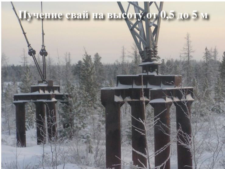
Неравномерное пучение свай под опорой
