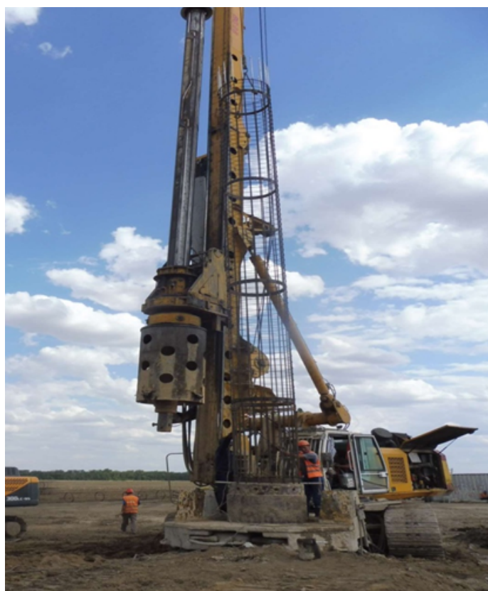
Рис.2 Изготовление буронабивных свай фундамента ВЭУ
