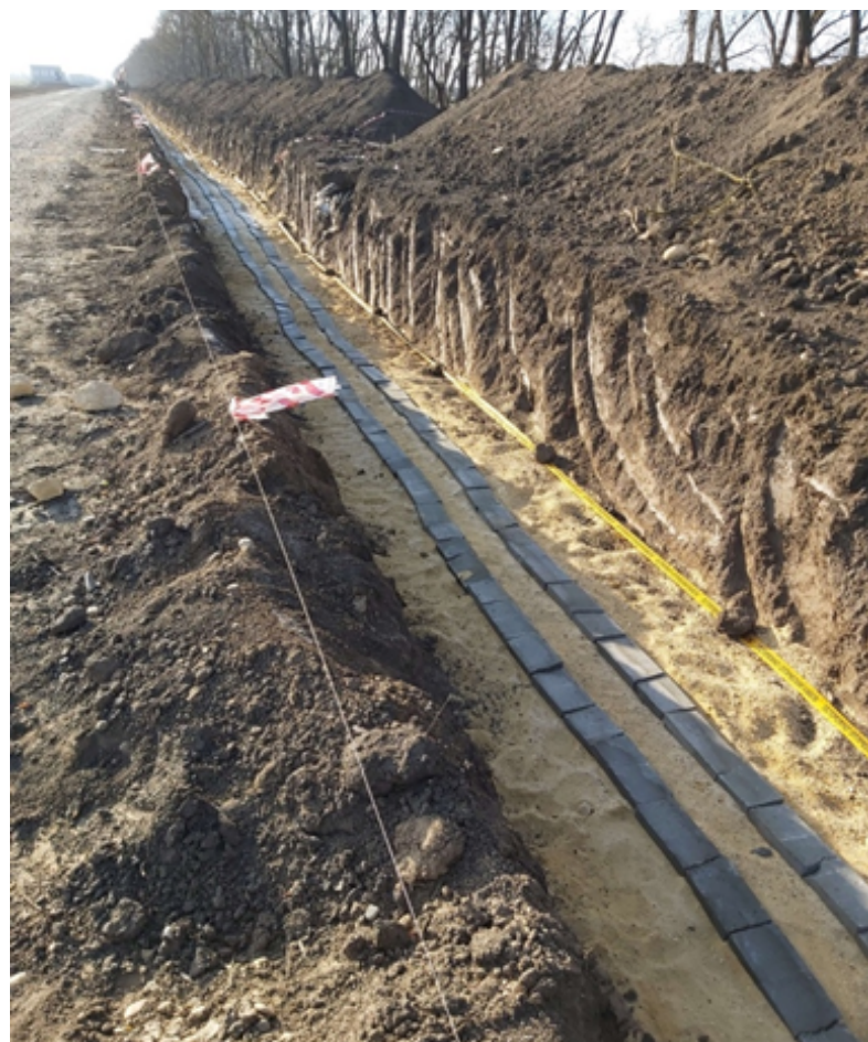
Рис. 6 Кабельная траншея
