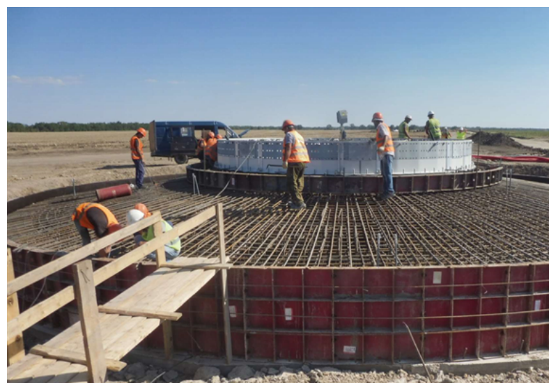
Рис. 3 Армирование ростерка фундамента ВЭУ
