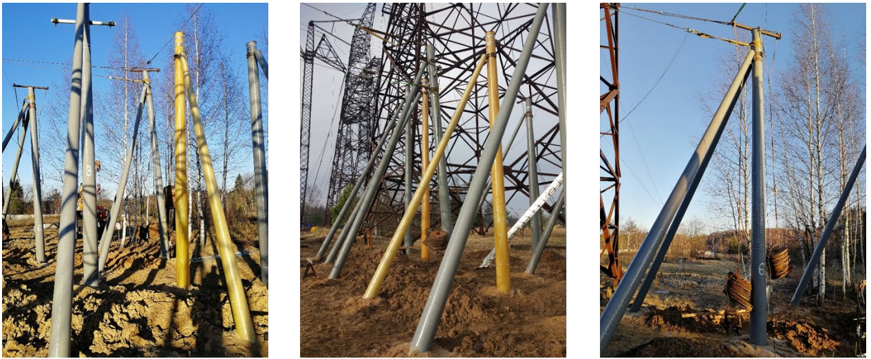
Рисунок 4 – Испытания анкерно-угловых опор на полигоне ОРГРЭС
