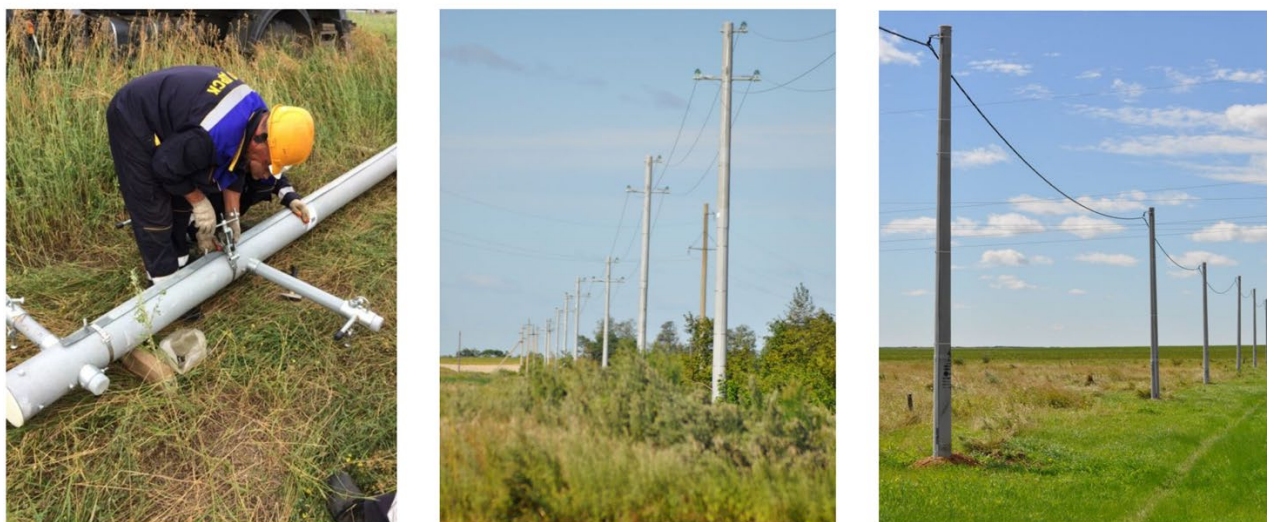
Рисунок 5 – Установка композитных опор в селе Волково Амурской области
