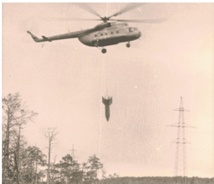
Рисунок 2. Эксперимент по сбросу специального полого фундамента SF-1 весом 1,3 тонны при помощи вертолета Ми-8 в песчаные почвы с высоты 190 м (Сургут, 17.07.1992)
