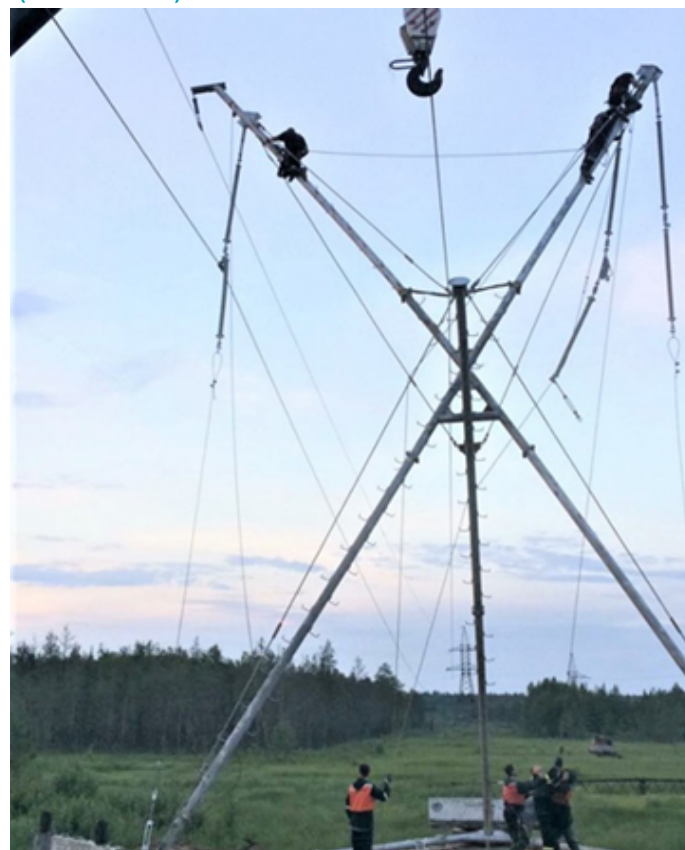
Рисунок 1. Доставка опоры вертолетом как готового моноблока (22.08.2013) и монтаж краном опоры, привезенной россыпью на автоплощадке (21-22.07.2017)
