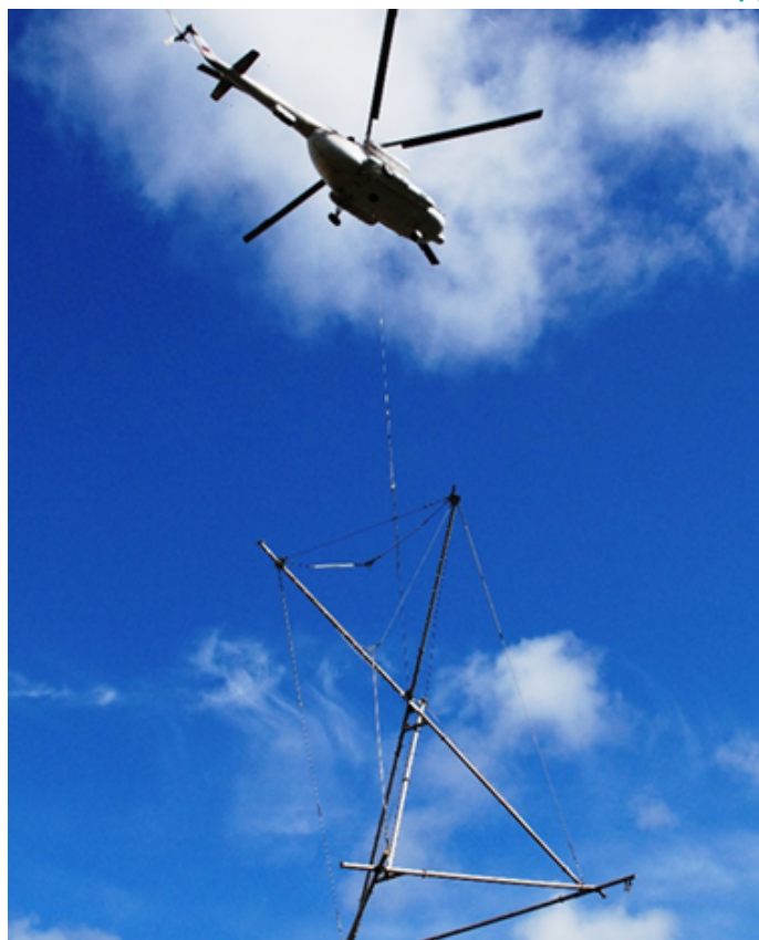
Рисунок 1. Доставка опоры вертолетом как готового моноблока (22.08.2013) и монтаж краном опоры, привезенной россыпью на автоплощадке (21-22.07.2017)
