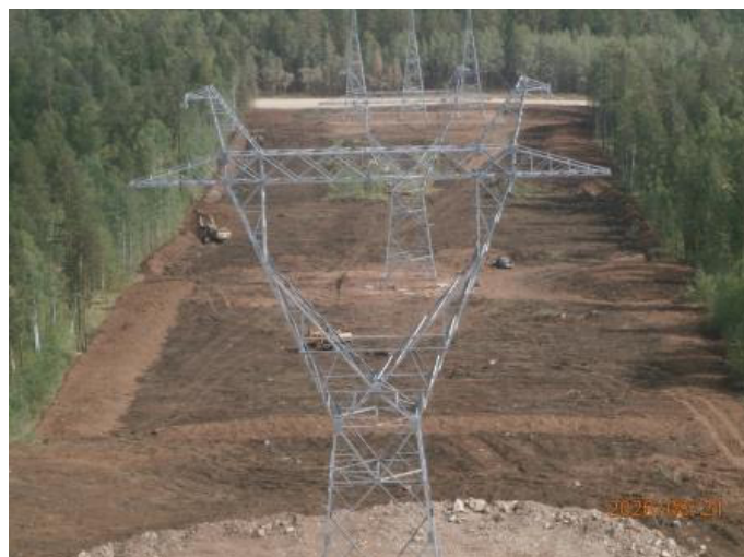
Фото 1. На строительстве ВЛ 500кВ Нижнеангарская – Усть-Кут.
