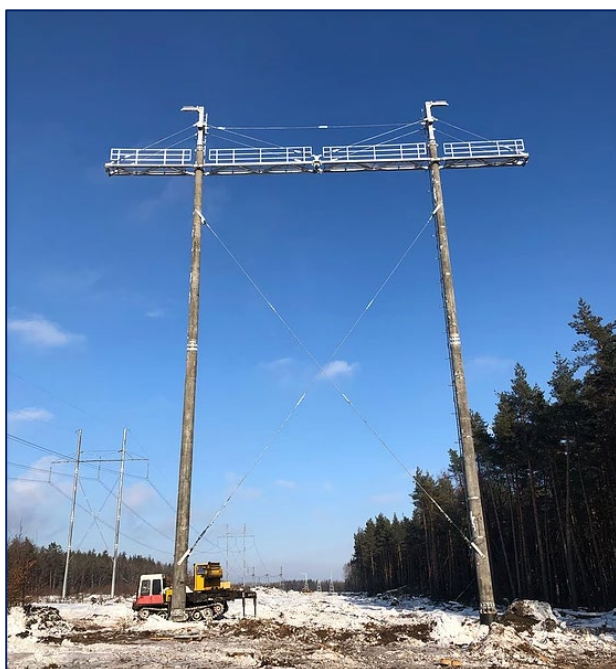
Рисунок 3 – Опора 2СПБ500-3В на ВЛ 500 кВ «Донская АЭС – Старый Оскол 2»
