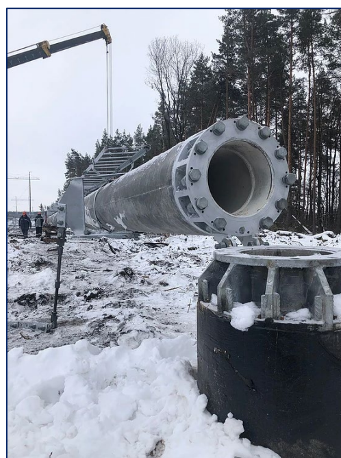
Рисунок 3 – Опора 2СПБ500-3В на ВЛ 500 кВ «Донская АЭС – Старый Оскол 2»
