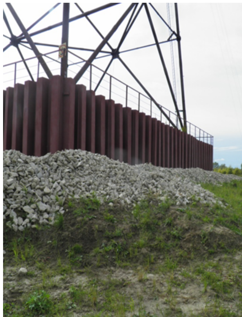
Рисунок 4. Переходная опора №839 после реконструкции
