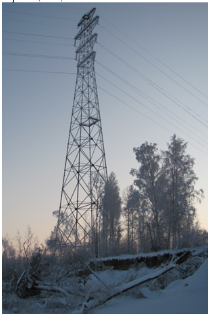
Рисунок 3. Переходная опора №839 до реконструкции
