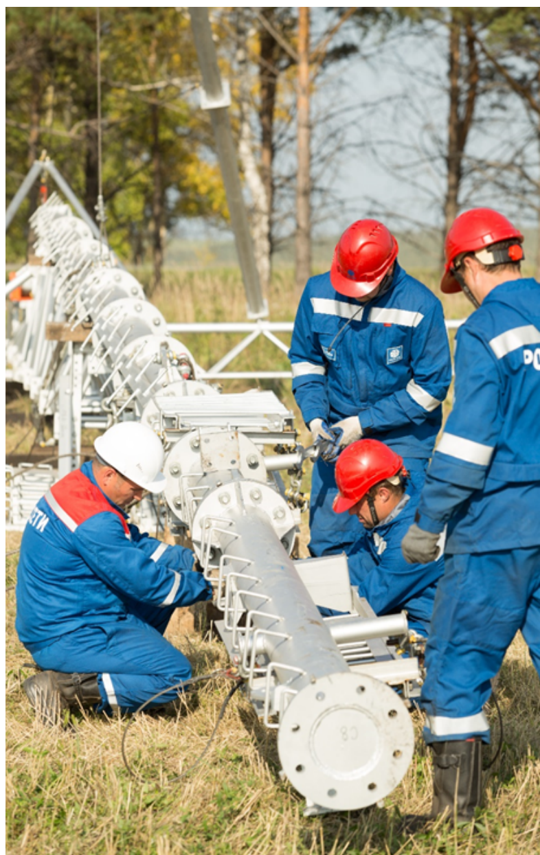
Рис. 3. Сборка опоры ПБМ.
