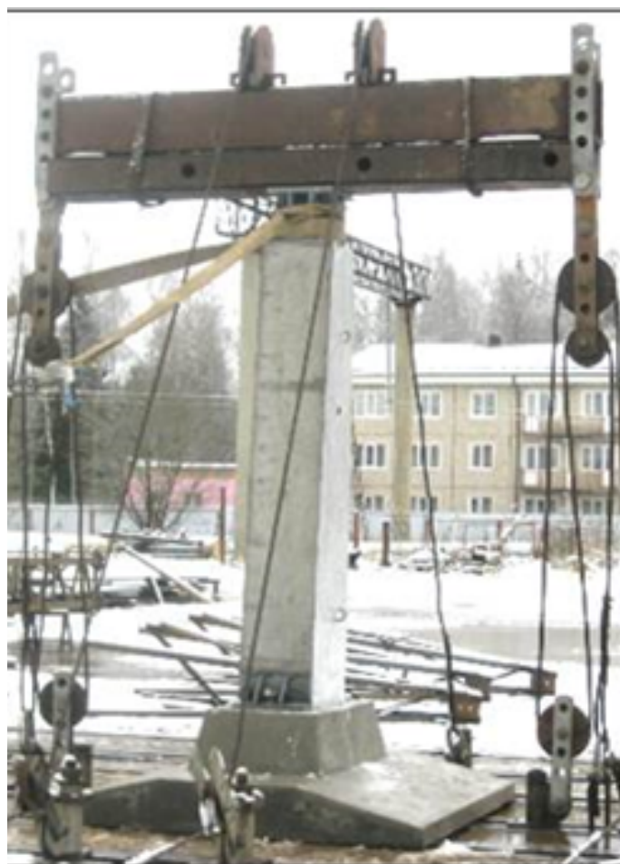
Рис. 7. Испытание на сжатие.
