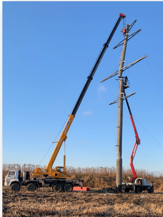
Рис. 8. Монтаж верхней секции
