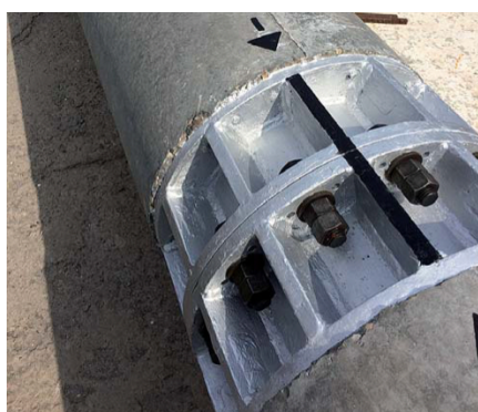
Рис. 1 а) Узел соединения секций. б) Перевозка секций длиной по 13 м
