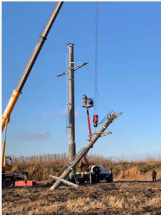
Рис. 7. Монтаж средней секции
