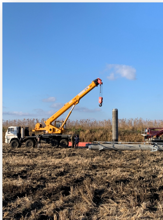
Рис. 6. Монтаж нижней (фундаментной) секции
