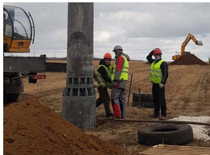
Установка опоры на фундамент
