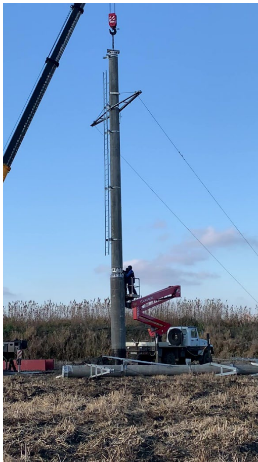
Монтаж средней секции опоры
