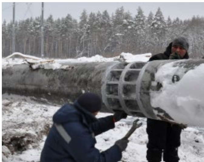
Сборка секций стойки
