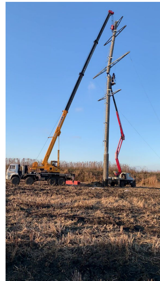
Монтаж верхней секции опоры
