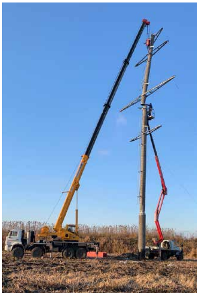
Рис. 5. Монтаж верхней секции
