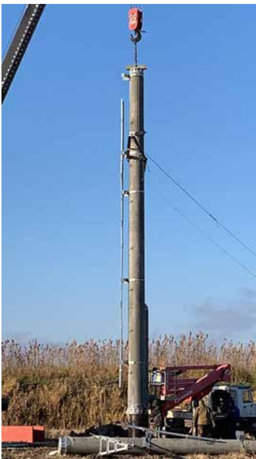
Рис. 4. Монтаж средней секции
