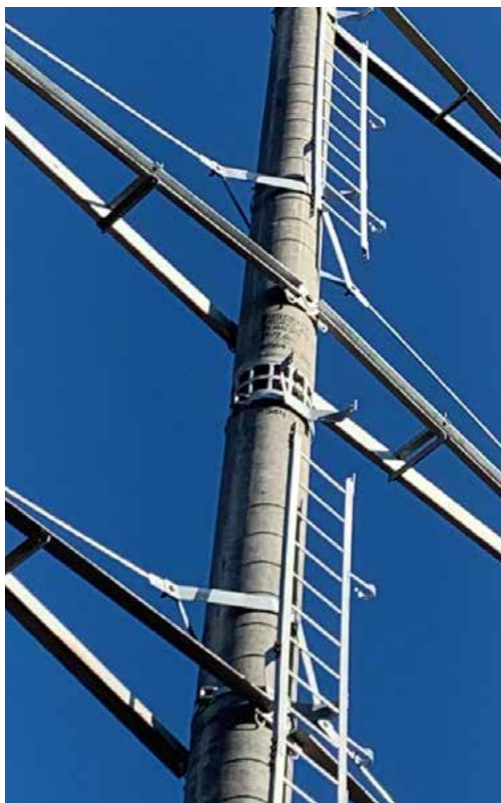
Рис. 2. Лестница для подъема на опору (этап монтажа конструкции)
