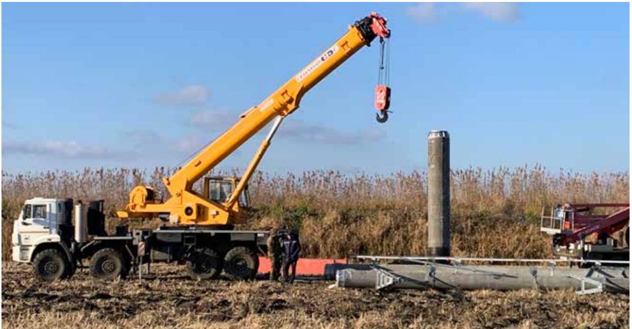
Рис. 3. Нижняя (фундаментная) секция, установленная до монтажа конической части опоры
