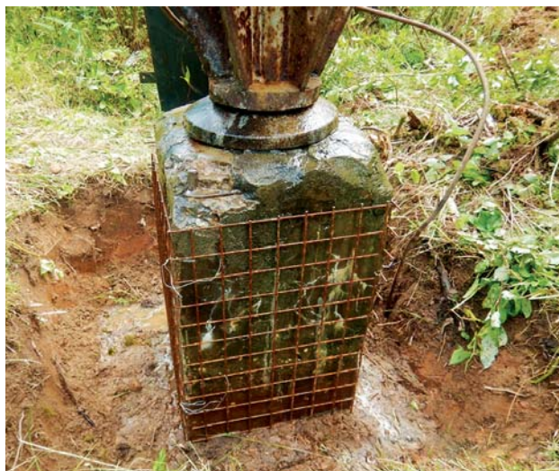
Рис. 6. Ремонт стойки фундамента
