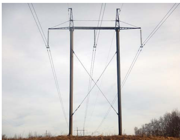
Рис. 3. Портальная опора типа ПВС330-1 с внутренними связями
