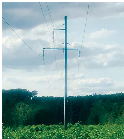
Рис. 1. Одностоечная свободностоящая опора
