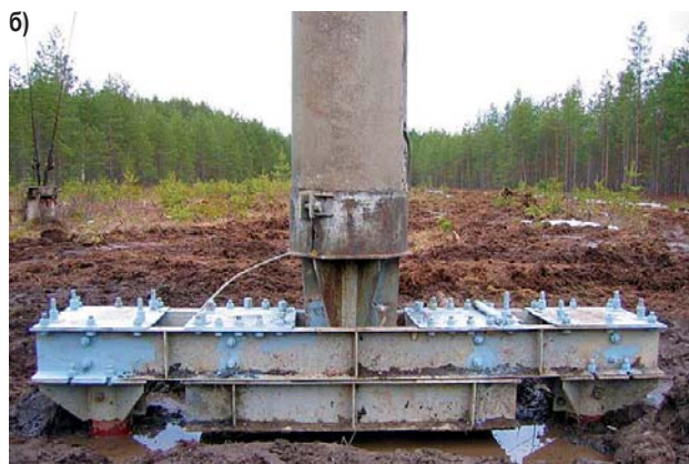
Рис. 7. Ремонт опоры № 89 ВЛ 330 кВ «Чудово-Окуловка»: а) проект замены грибовидного фундамента под стойку опоры на оттяжках; б) готовая конструкция фундамента из винтовых свай
