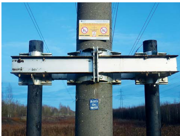
Рис. 9. Закрепление стойки опоры № 151 на ВЛ 220 кВ Выру — Кингисеппская при помощи винтовых свай
