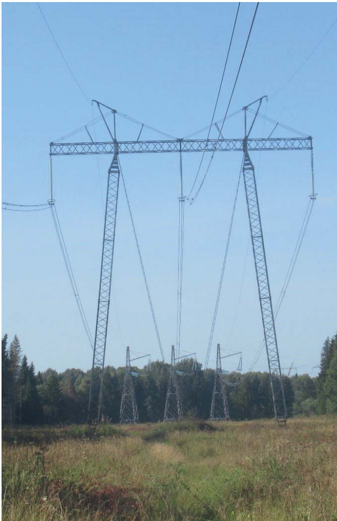
Рис. 2. Опоры ВЛ 500 кВ: а) ПСЦ-1 на оттяжках; б) П-2 свободностоящая
