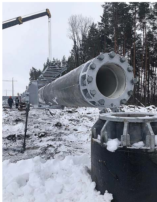
Рис. 12. Фундамент опоры 2СПБ500-3В
