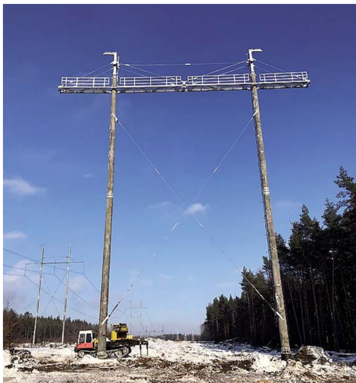
Рис. 11. Портальная железобетонная опора 2СПБ500-3В на ВЛ 500 кВ «Донская АЭС – Старый Оскол 2»
