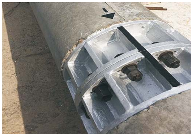
Рис. 2. Внутренний фланец для соединения секций (типовое решение)
