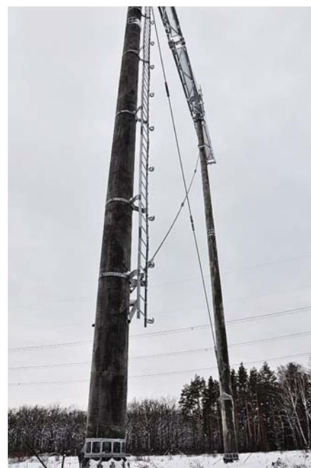
Рис. 8. Лестница опоры с анкерными петлями
