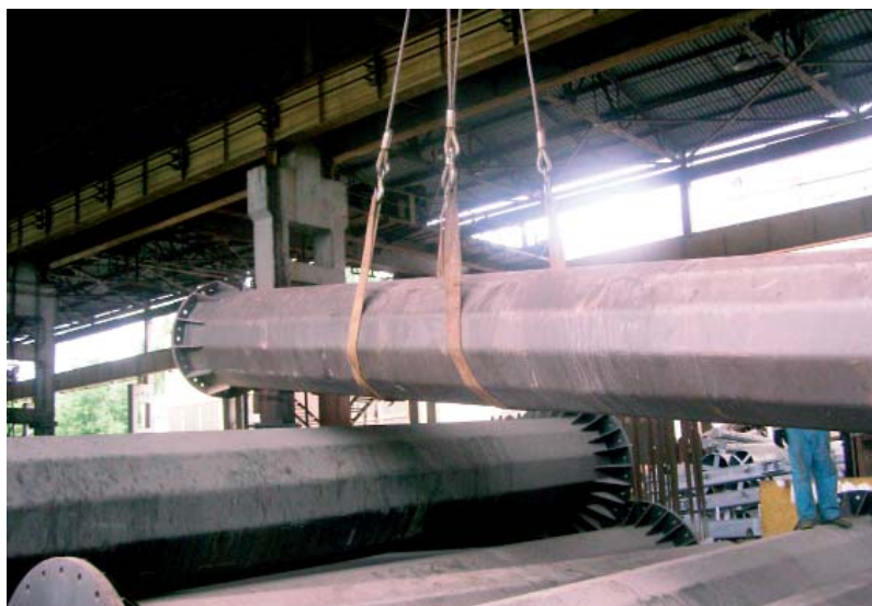
Рис. 3. Процесс складирования фундаментов из сваи-оболочки многогранного сечения в заводских условиях
