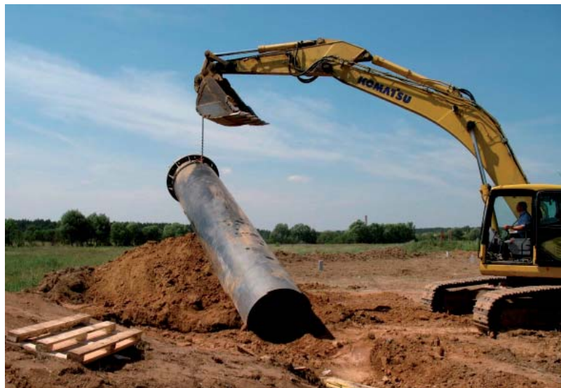
Рис. 4. Погружение фундамента в пробуренный котлован при помощи экскаватора
