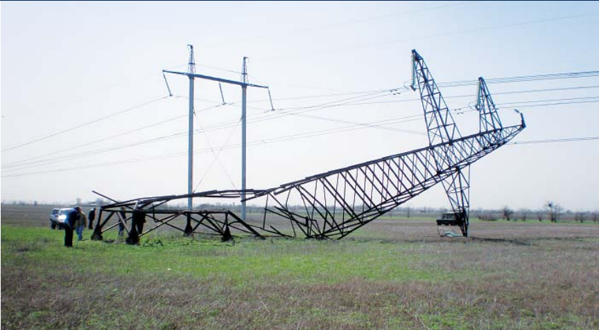
Рис. 2. Аварийная ситуация на ВЛ 330 кВ Н. Каховка — Джанкой в апреле 2013 года
