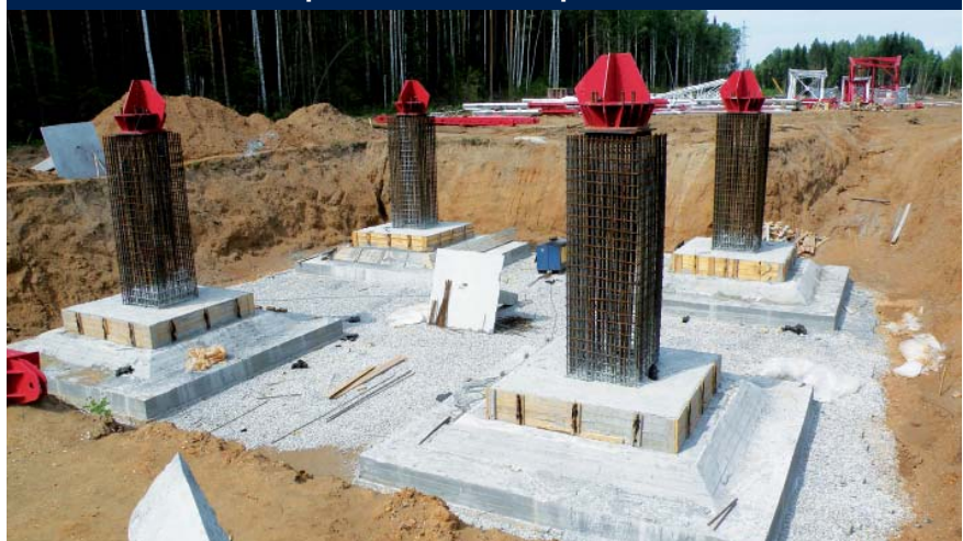
Рис. 2. Монолитные железобетонные фундаменты для закрепления опоры перехода ВЛ 220 кВ Пермская ГРЭС — Соболи-1,2 через Камское водохранилище
