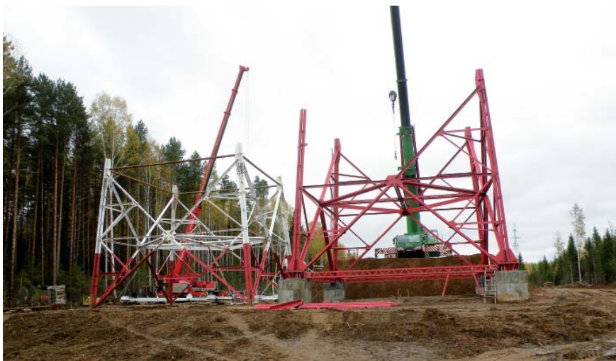
Рис. 3. Монтаж переходной опоры ВЛ 220 кВ Пермская ГРЭС — Соболи-1,2 через Камское водохранилище
