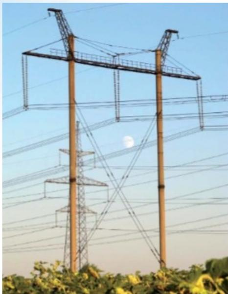
Опора из секционированных стоек
