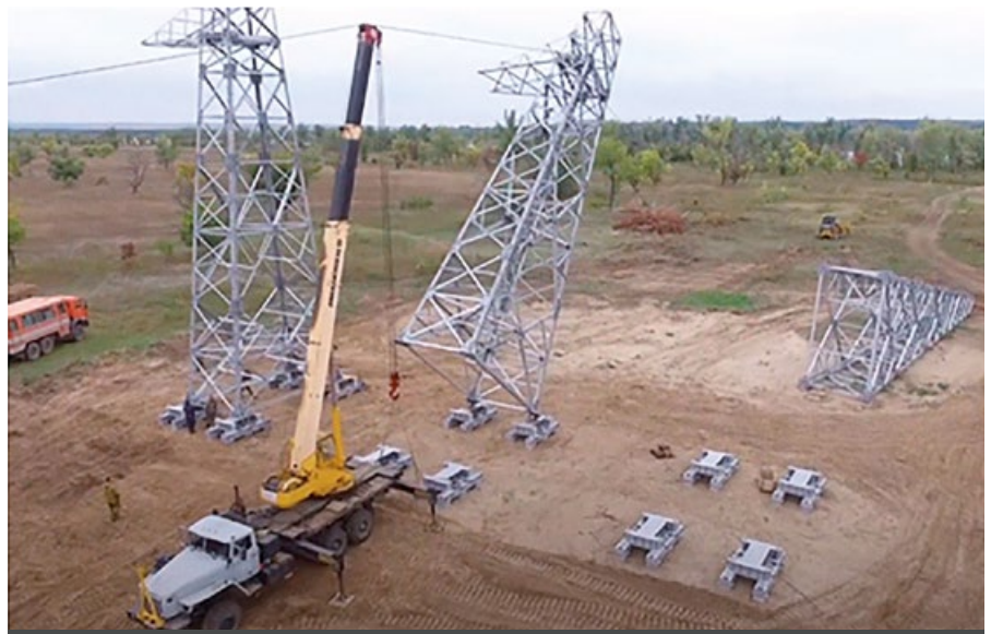
Рис. 1. Установка концевых опор на фундамент из составных свай при реконструкции перехода ВЛ 220 кВ через р. Волгу в районе Балаково
