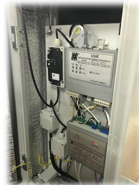
Шкаф пункта контроля, сбора и обработки информации
