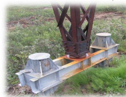
Опора с оттяжками установлена на новый фундамент (Северо-Запад)
