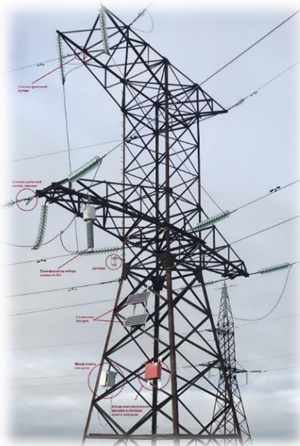
Установленное оборудование на опоре
