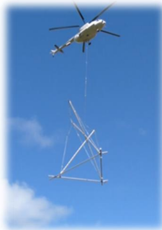
Доставка и установка временной опоры ПРХ-220
