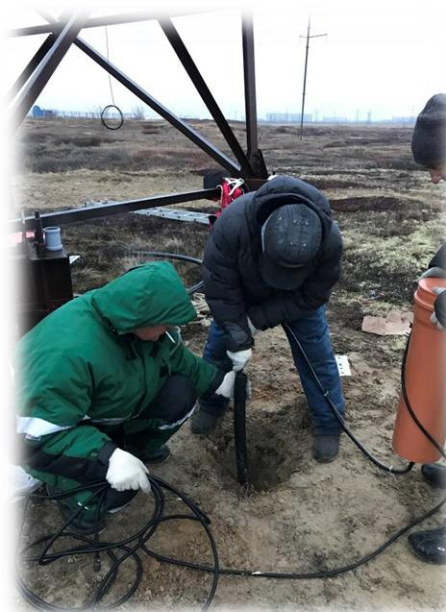
Установка термокосы
