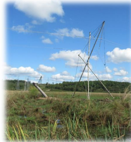
Доставка и установка временной опоры ПРХ-220
