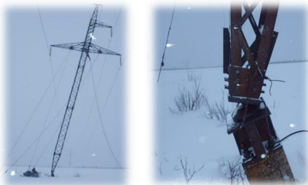
Наклон опоры с оттяжками в следствие выдавливания фундамента (Северо-Запад)
