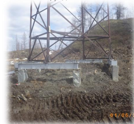
После перестановки на новые фундаменты
