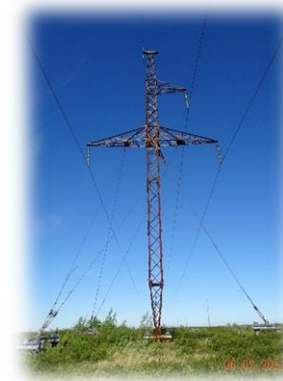
Опора с оттяжками установлена на новый фундамент (Северо-Запад)
