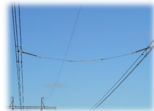
Установленные межфазные распорки
