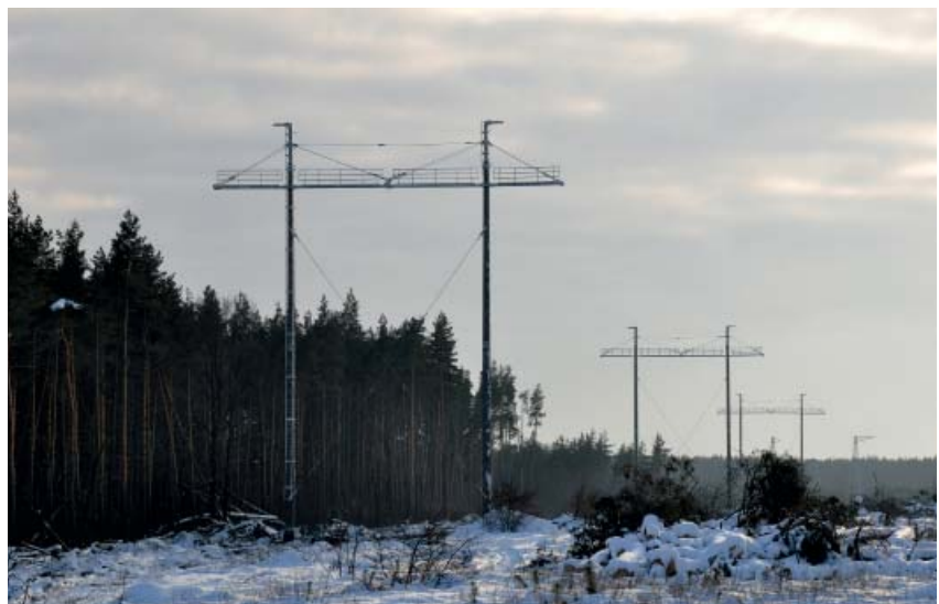
Рис. 4. Опоры 2СПБ500-3В на ВЛ 500 кВ Донская АЭС — Старый Оскол-2
