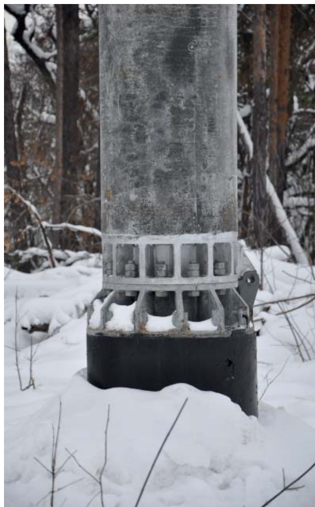
Рис. 3. Узел соединения стойки с фундаментом
