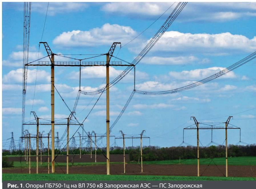
**Рис. 1.** Опоры ПБ750-1ц на ВЛ 750 кВ Запорожская АЭС — ПС Запорожская
