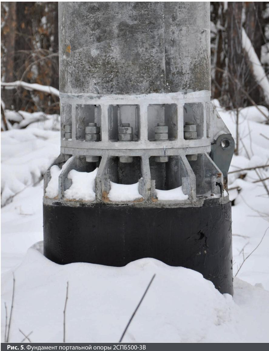
Рис. 5. Фундамент порталной опоры 2СПБ500-3В
