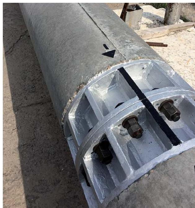
Рис. 1. Фланцевое соединение секций
