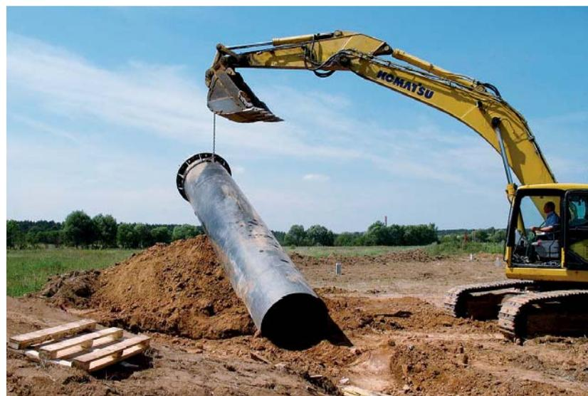
Рис. 4. Погружение фундамента в пробуренный котлован при помощи экскаватора
