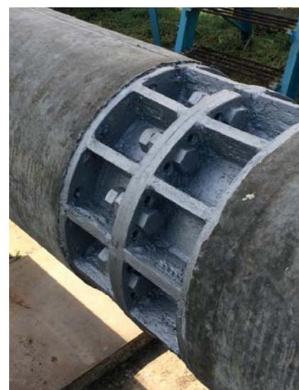
Узел соединения секционированной стойки
