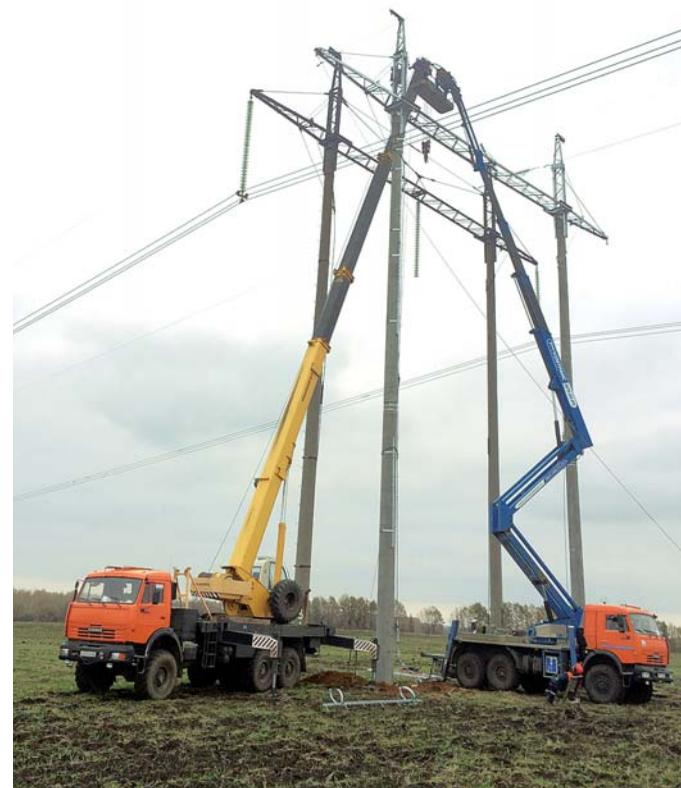
Рис. 4. Замена опоры ПБ500-5н на ПБ500-5н(с) на ВЛ 500 кВ Тамбов — Пенза 2
