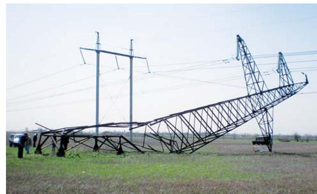
Рис. 2. Аварийная ситуация на ВЛ 330 кВ Н. Каховка — Джанкой в апреле 2013 года
