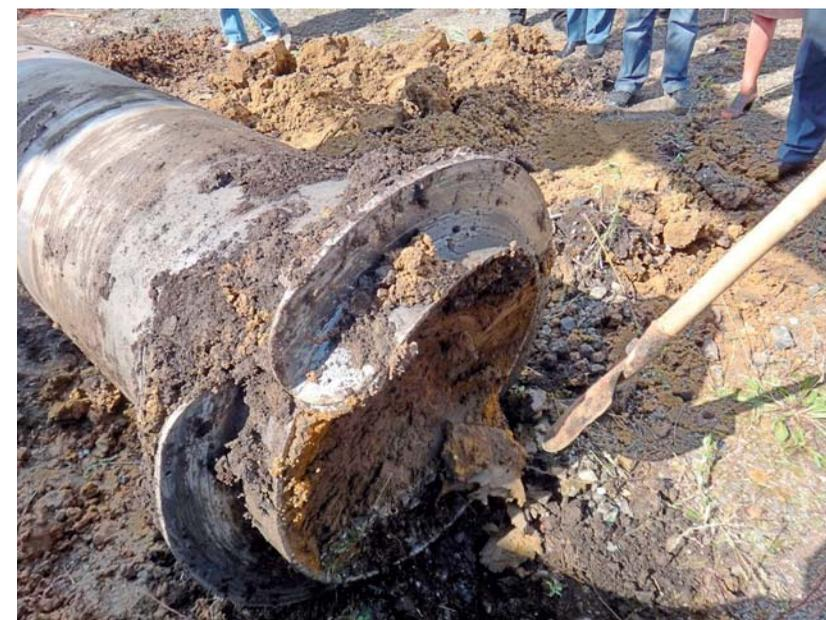
Рис. 6. Использование трубчатых фундаментов с винтовыми лопастями при строительстве ВЛ 500 кВ Восход — Витязь
